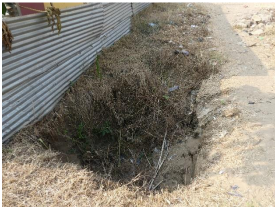
FIGURE 9 : Bassin de rétention captant l'eau s'écoulant sur l'allée adjacente (photographie prise à Kinshasa dans le quartier de Kimuenza)
