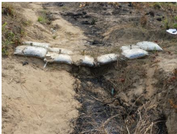
FIGURE 44 : Ouvrages dont le taux d'infiltration fut calculé (de gauche à droite et de haut en bas) : bassin recouvert de déchets, bassin ensablé, mur de sacs de sable et bassin bien entretenu
