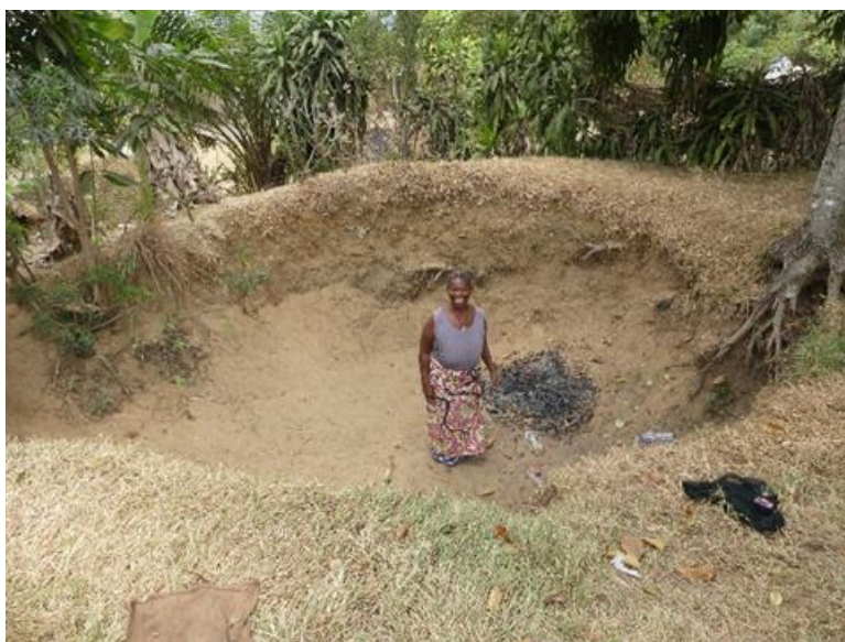
FIGURE 29 : Bassin de rétention avec la Maman qui l'a creusé et qui l'entretient (photographie prise à Kimwenza)
