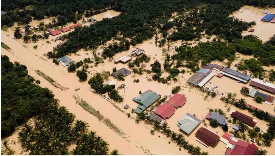
Figure 18 : Inondations en Malaisie (2022) où l'eau s'écoule dans les deux directions horizontales. Tirée d'un article de « Futura » (Futura-sciences).
