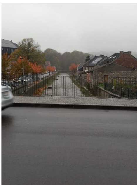
Figure 57 : Vue du côté aval de la Hoëgne très rectiligne depuis le pont de séparant les deux places. Photo prise lors de la visite sur place le 19 novembre 2022.
