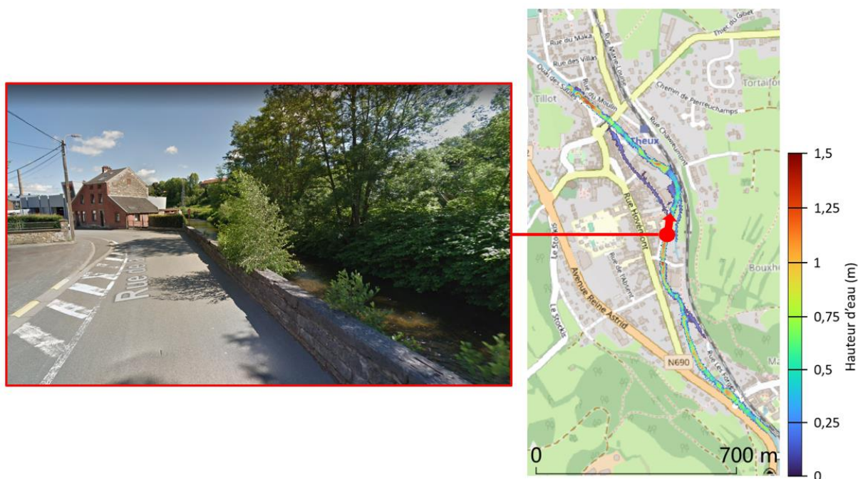
Figure 84 : Vue (tirée de Google Maps) depuis la rue de la Hoëgne illustrant la présence de muret entre la Hoëgne et la rue permettant de retarder le débordement.
