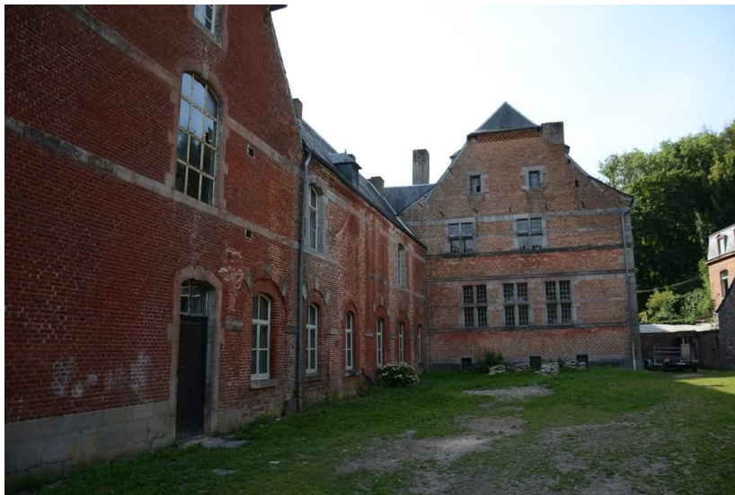
Annexe 9. Relevé photographique personnel / Chapelle- Façade Nord (Ailes des converses) – Ancienne Hôtellerie
