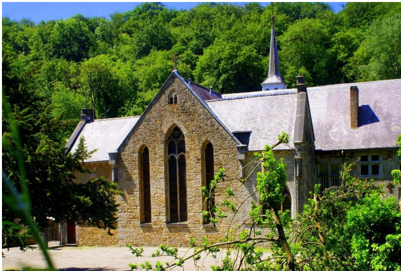
Annexe 7. Relevé photographique personnel / Façade Sud (Quartier de l'abbesse) – Eglise
