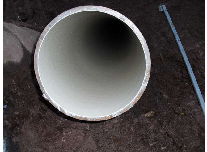
Figure 2-25: Réhabilitation de conduites par projection d'une résine [58].
