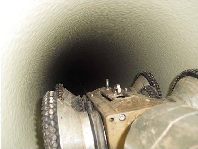
Figure 2-25: Réhabilitation de conduites par projection d'une résine [58].
