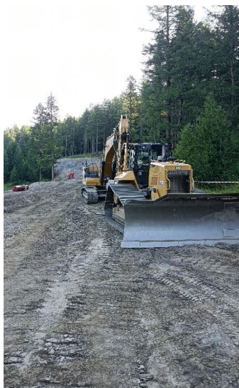
Figure 35 : travaux pour le télési de la brune
