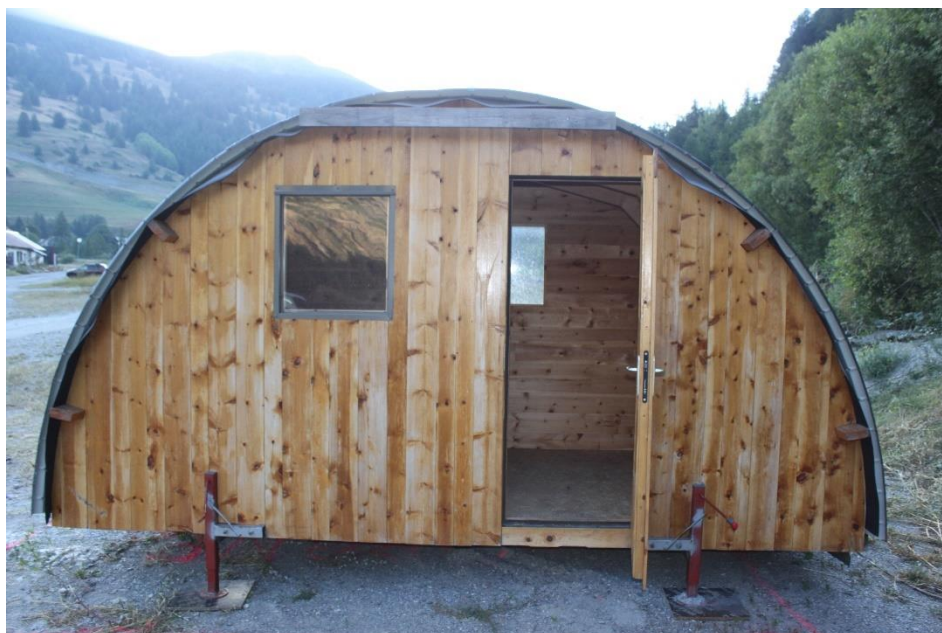
Annexe 3 : cabane héliportable de la commune d'Abriès-Ristolas
