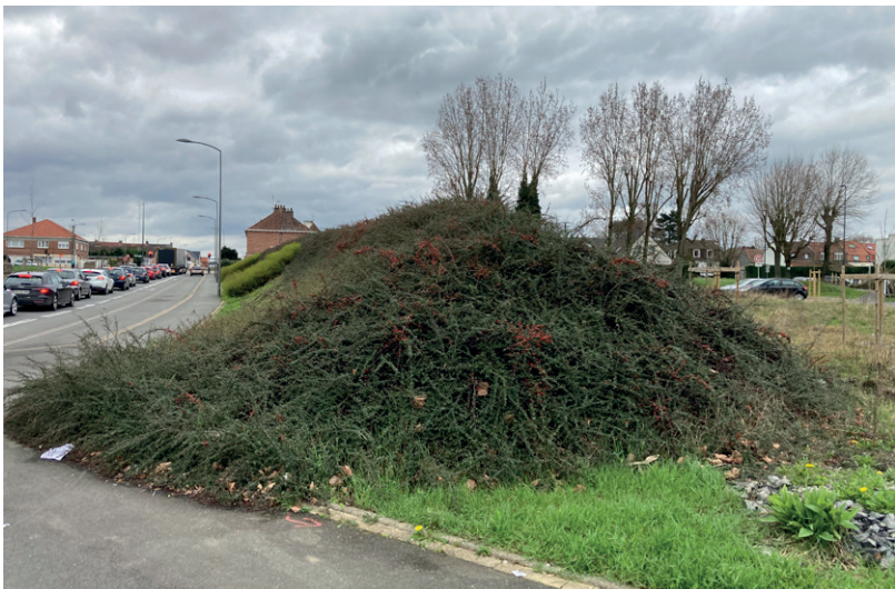
Fig 2 : Talus antibruit, protection pour le bâti résidentiel à Wattrelos, France
