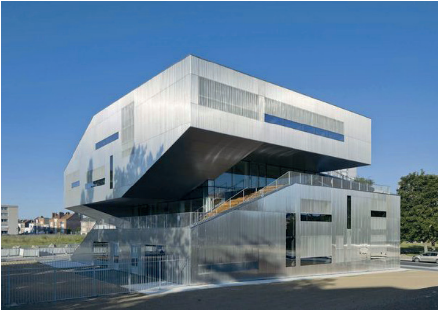
Fig 1 : Centre social de l'Arbrisseau, angle nord-est du bâtiment
