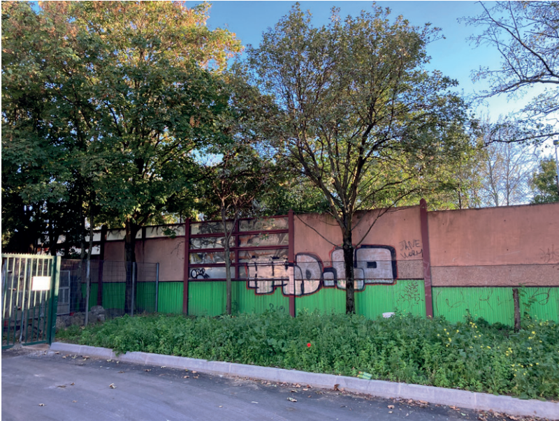
Palissade de sécurité, Lille sud Octobre 2023 © Dumez A
