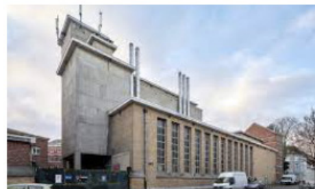
Centrale thermique - AG Verpa
