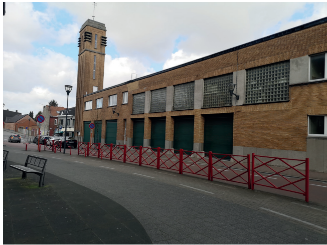
20. vue depuis rue sur la caserne et gymnase
