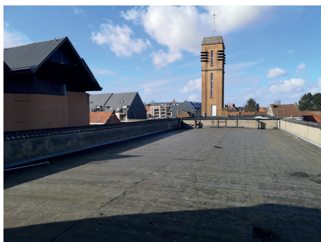
24. vue sur l'arsenal depuis terrasse
