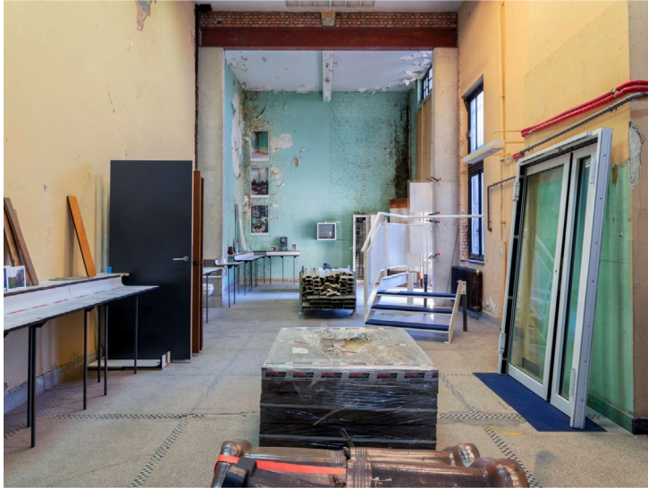
Dépose et repose sur site
