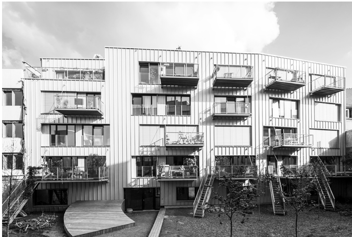
Fig 9. Vue du projet Brutopia à Bruxelles, source Archdaily 43
