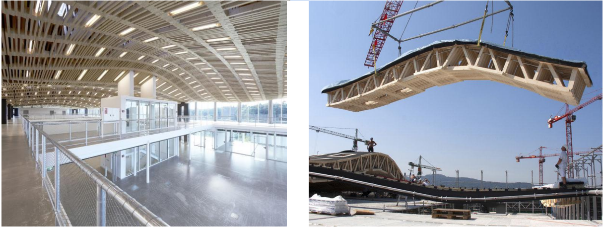
Figure 12 : « The Sequential Roof » : structure finie (à gauche), montage partiel (à droite). [8]
