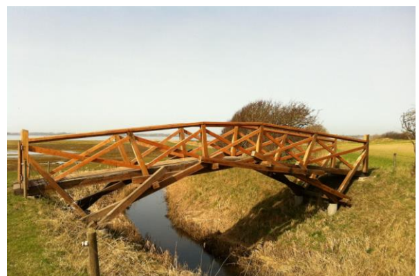
Figure 10 : Passerelle à Morsø, Danemark [14]
