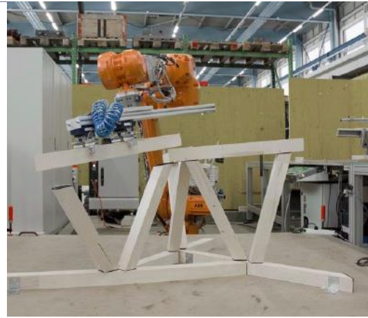
Figure 15 : Montage de la structure en joints en T par robot. [7]
