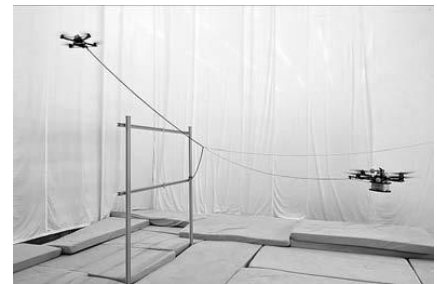
Figure 11 – Construction par des drones d'une structure filaire avec un nouveau degré de liberté
