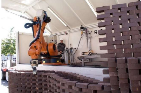
Figure 5 – Pike Loop en construction en 2009 à New-York (Ce robot n'est pas SAM) [10]
