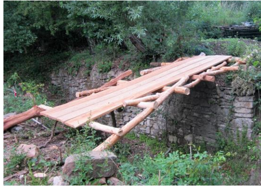
Figure 8 : Pont formé à partir de grumes [7]
