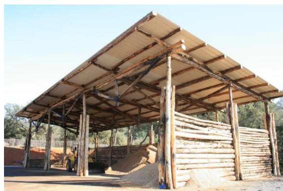
Figure 7 : Hangar de stockage à la Môle [10]
