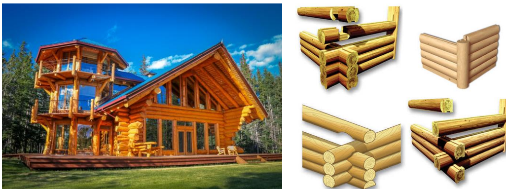
Figure 1 : Construction en grumes empilées [17] [11]
