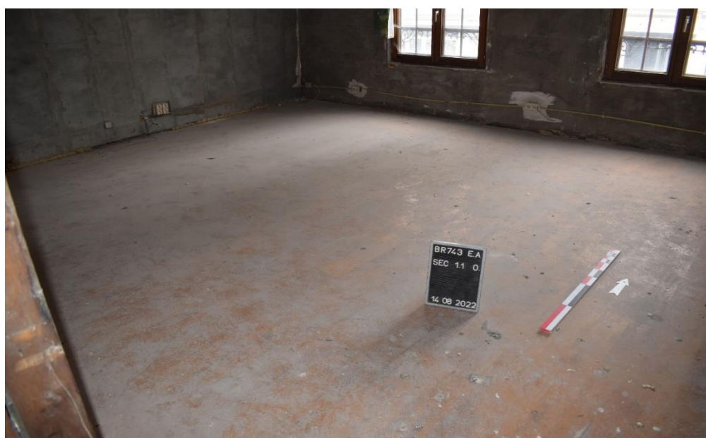
Fig. 99. Revêtement de sol, EA S1.1 Revêtement de sol, cliché de F. Van Boxem
