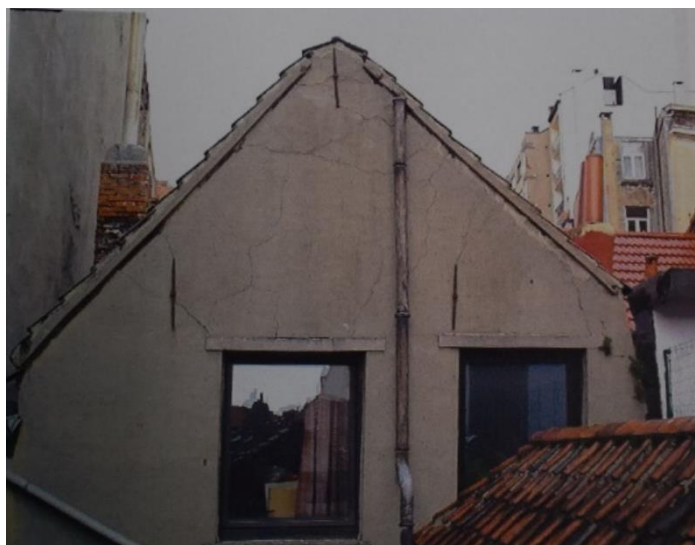
Fig. 30. Façade postérieure du bâtiment avant, 2004, © Urban.brussels.
