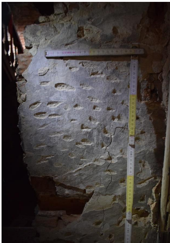
Fig. 232. Détail de la couche de finition entaillée (US 1200), EB S1.4 MN, cliché de F. Van Boxem
