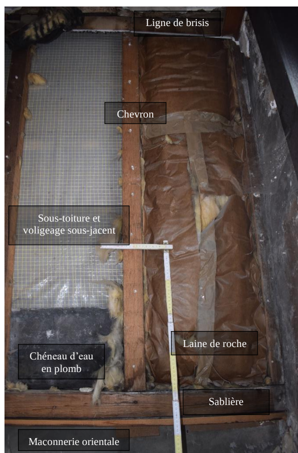
Fig. 137. Détail du brisis, EA S2.2 Couvrement, cliché de F. Van Boxem
