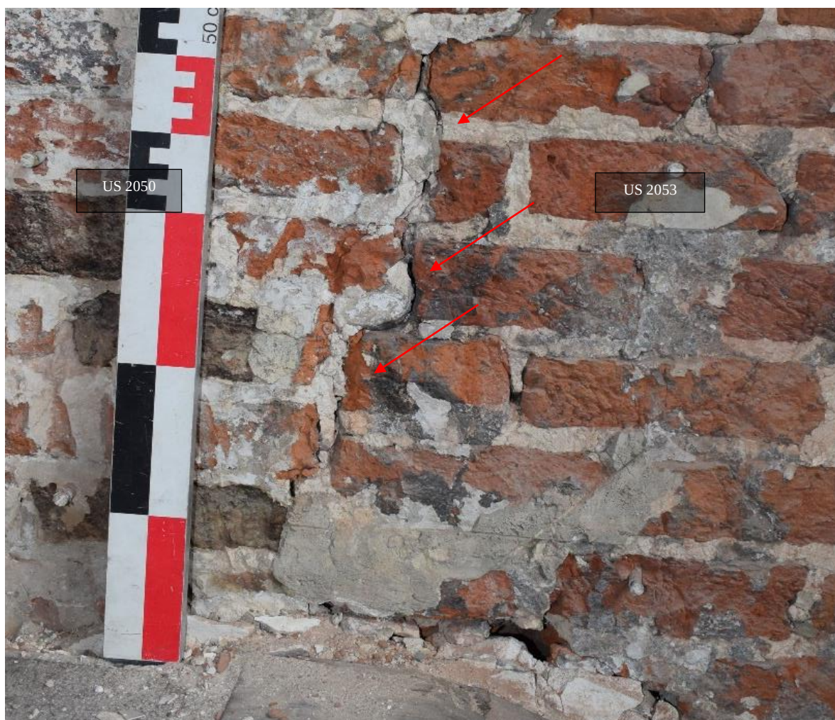
Fig. 132. Détail du mortier de l'interface entre les US 2050 et 2053, EA S2.2 ME, cliché de F. Van Boxem
