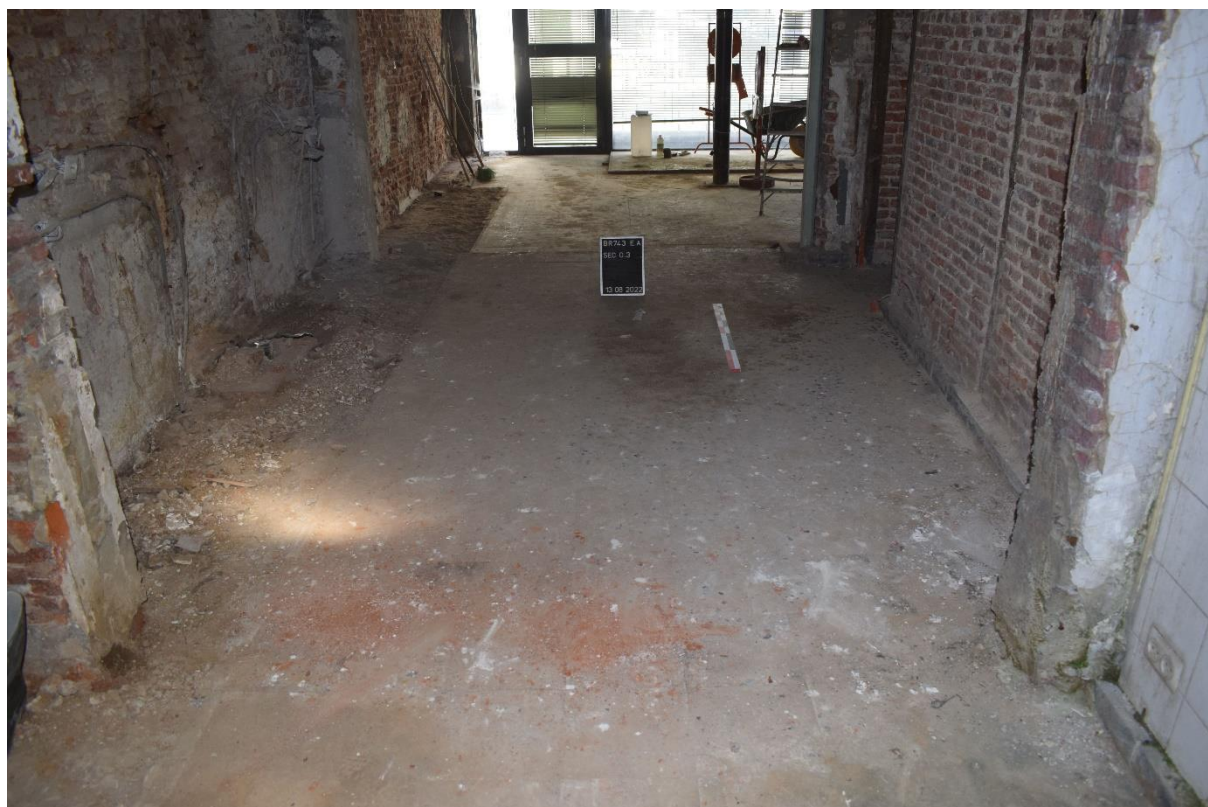
Fig. 91. Granito du revêtement de sol, EA S0.3 Revêtement de sol, cliché de F. Van Boxem
