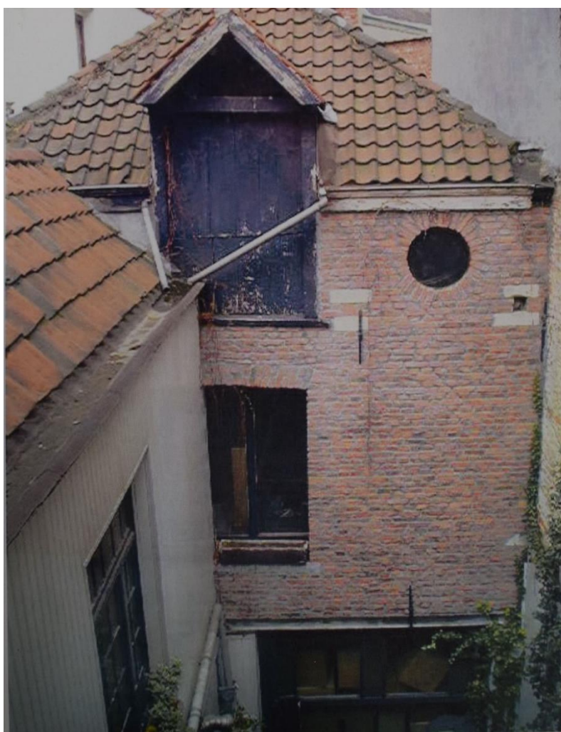
Fig. 31. Façade antérieure du bâtiment arrière, 2004, © Urban.brussels.
