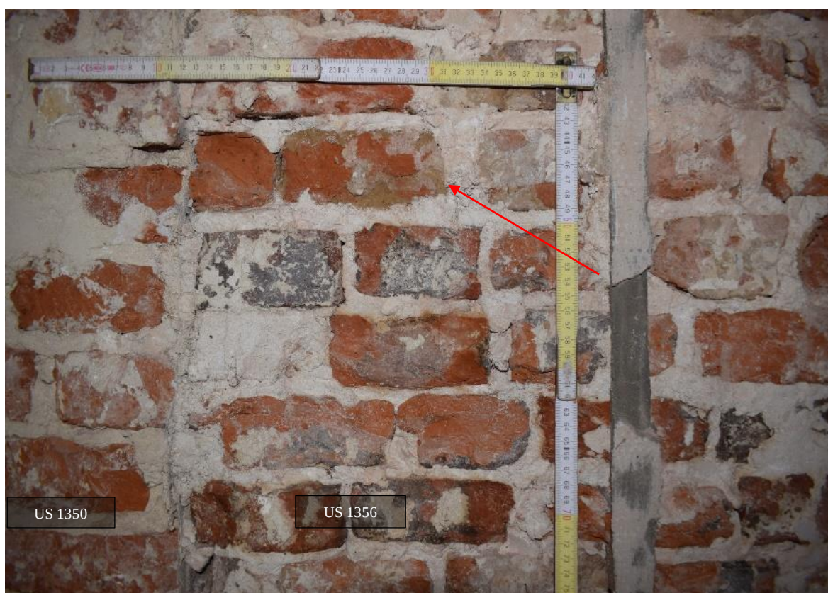
Fig. 96. Eléments de remploi et gangue brune (indiquée par la flèche) de l'US 1356, EA S1.1 MS, cliché de F. Van Boxem
