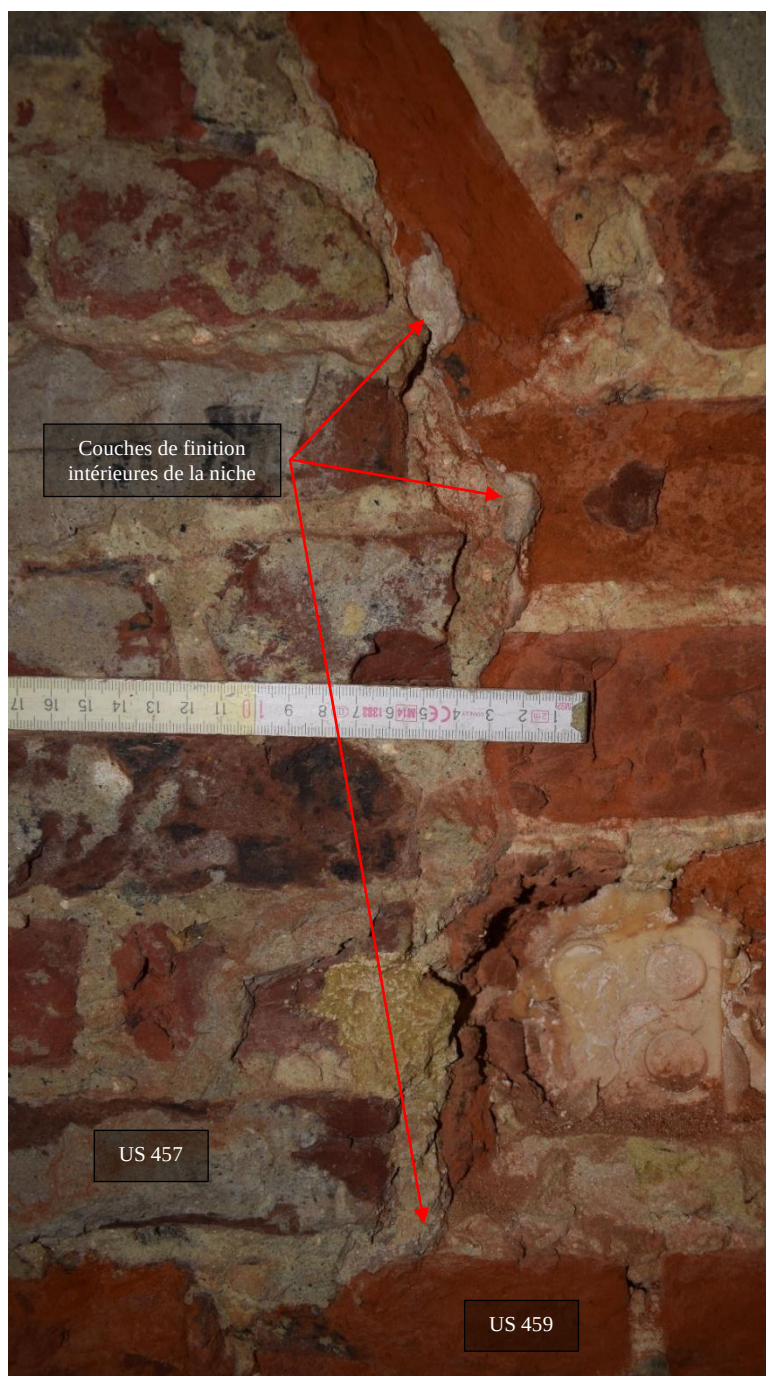
Fig. 212. Détail des couches de finitions de la paroi nord de la niche (US 457), EC S0.5 MO, cliché de F. Van Boxem
