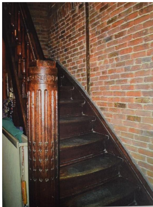
Fig. 26. Balustre de départ de l'escalier du rez-de-chaussée du bâtiment avant, 2004, © Urban.brussels.
