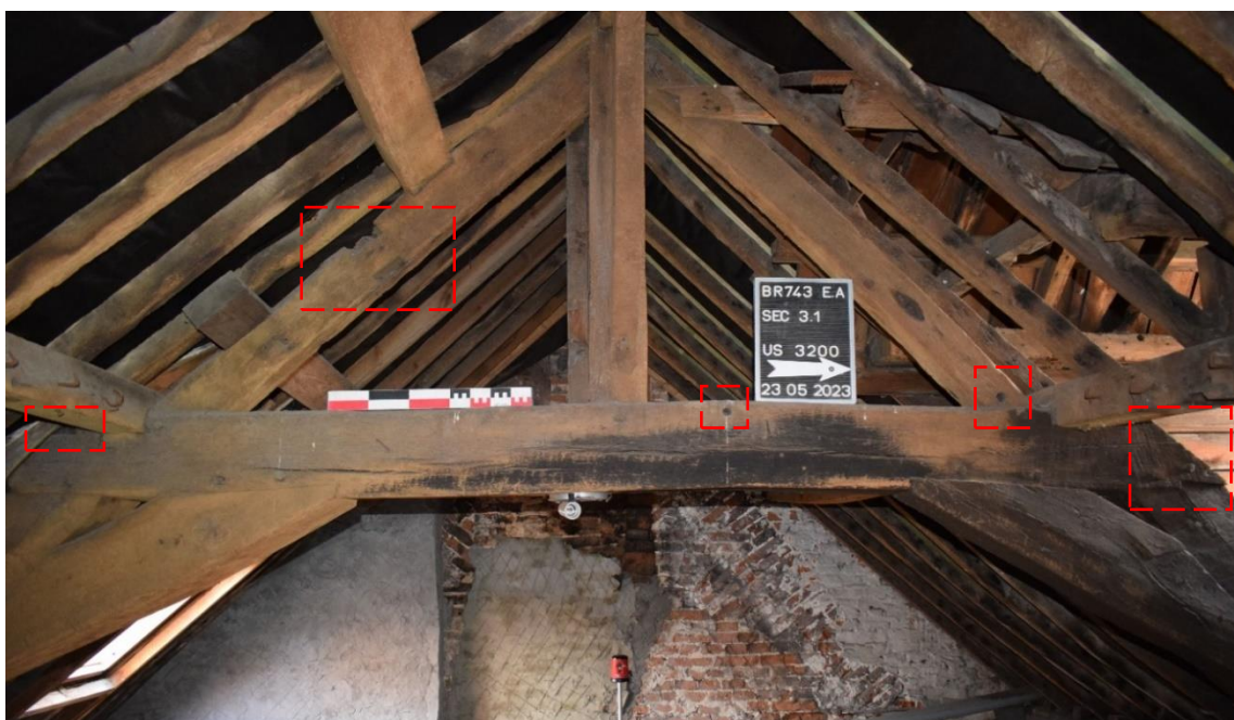
Fig. 153. Traces d'assemblages vides (US 3200) vues depuis l'est, EA S3.1 Couvrement, cliché de F. Van Boxem
