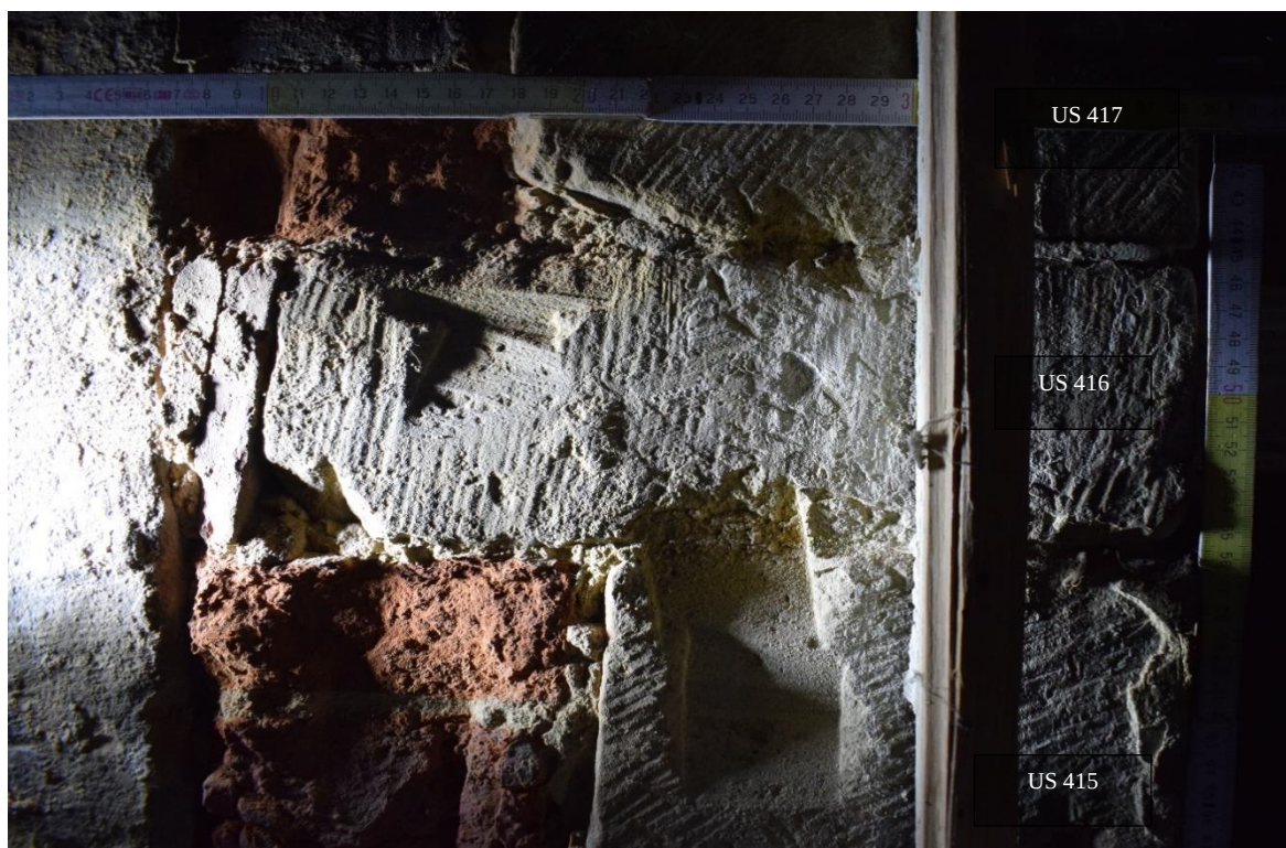
Fig. 181. Superposition de traces de taille, EB S0.4 MN, cliché de F. Van Boxem
