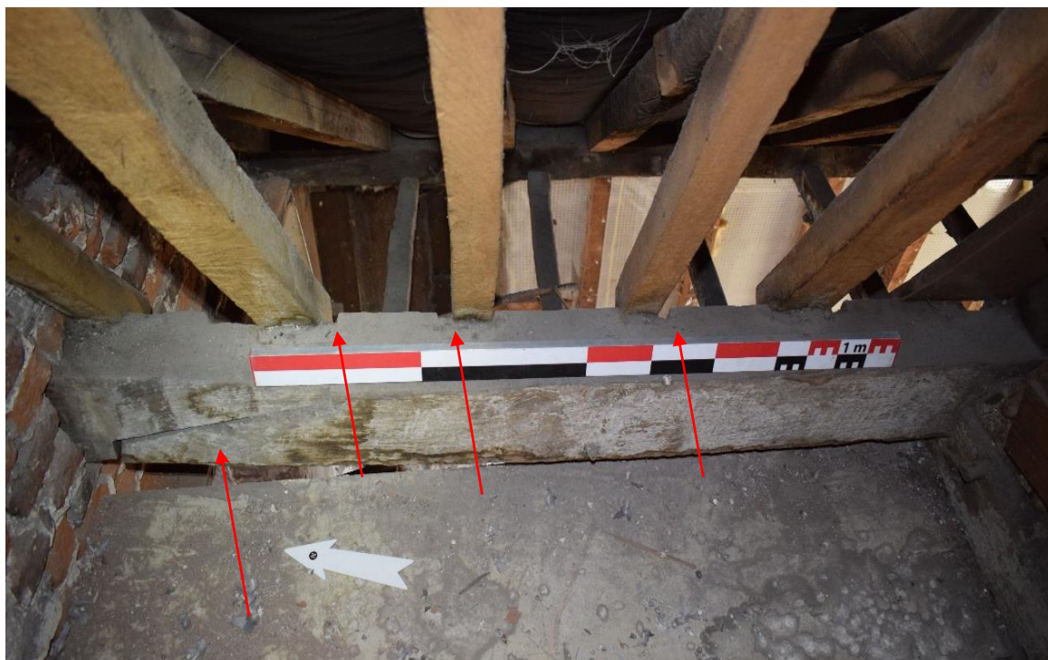
Fig. 164. Détail des assemblages de l'US 3102, EA S3.2 MN, cliché de F. Van Boxem
