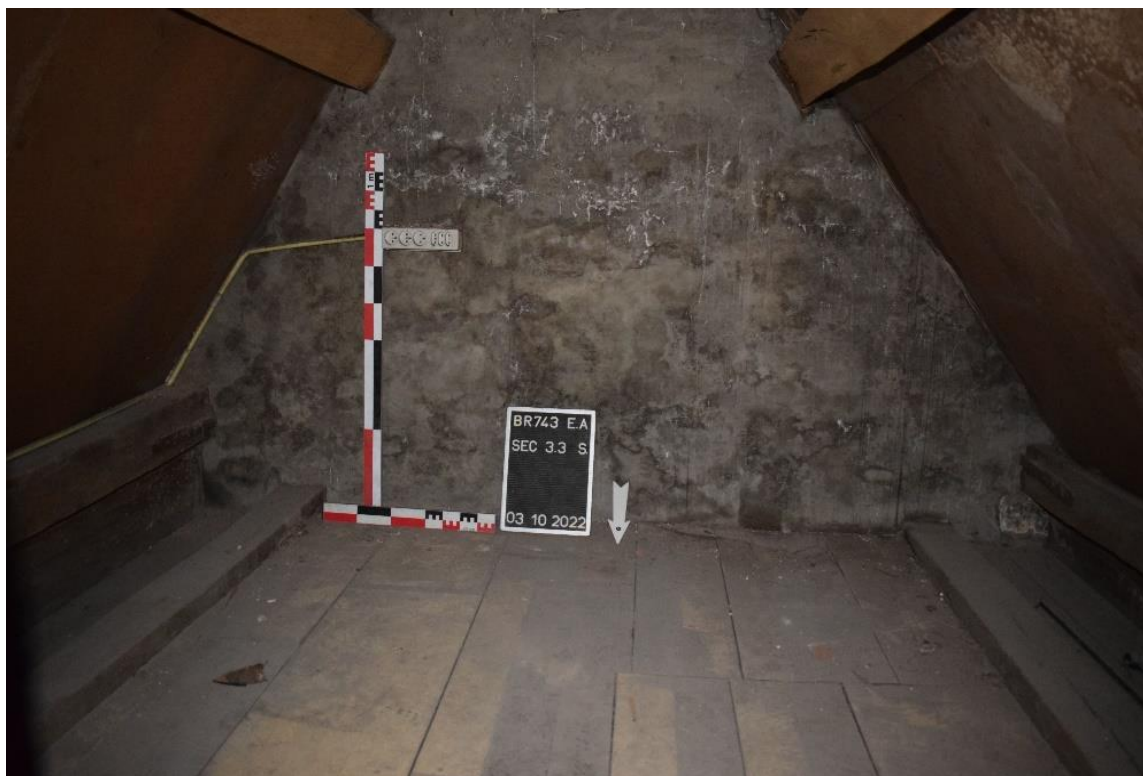
Fig. 169. Vue de la maçonnerie sud, du couvrement et du revêtement de sol, EA S3.3, cliché de F. Van Boxem
