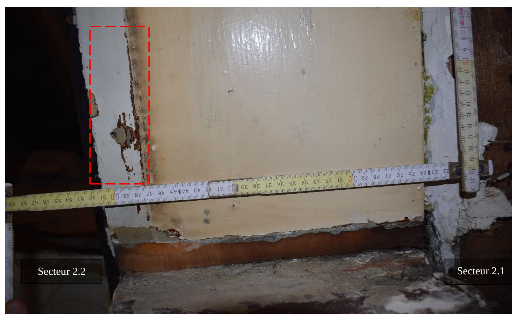
Fig. 130. Détail des finitions de la face inférieure du linteau (US 2107), traitement en faux-bois encadré, EA S2.2 MN, cliché de F. Van Boxem
