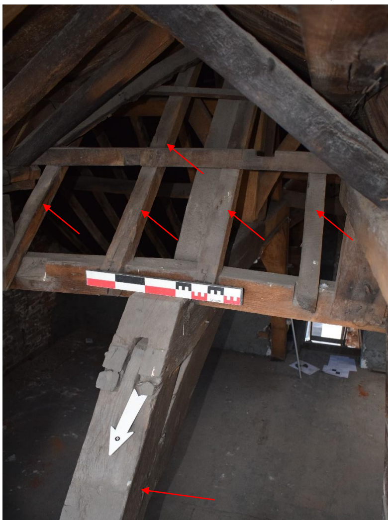
Fig. 159. Clous arrachés ou encore présents et ligne noire sur les chevrons et la ferme de charpente, EA S3.1 Couvrement, cliché de F. Van Boxem
