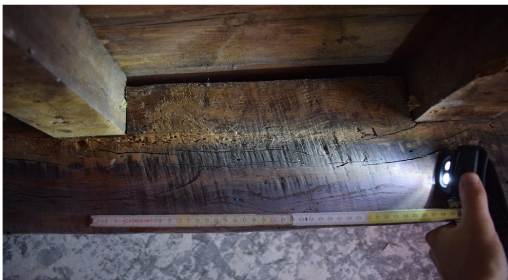
Fig. 123. Traces de sciage face latérale est (US 2201), EA S2.1 Couvrement, cliché de F. Van Boxem
