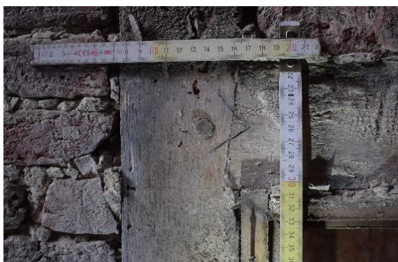
Fig. 101. Détail marque d'assemblage sud du linteau, EA S1.2 ME, cliché de F. Van Boxem
