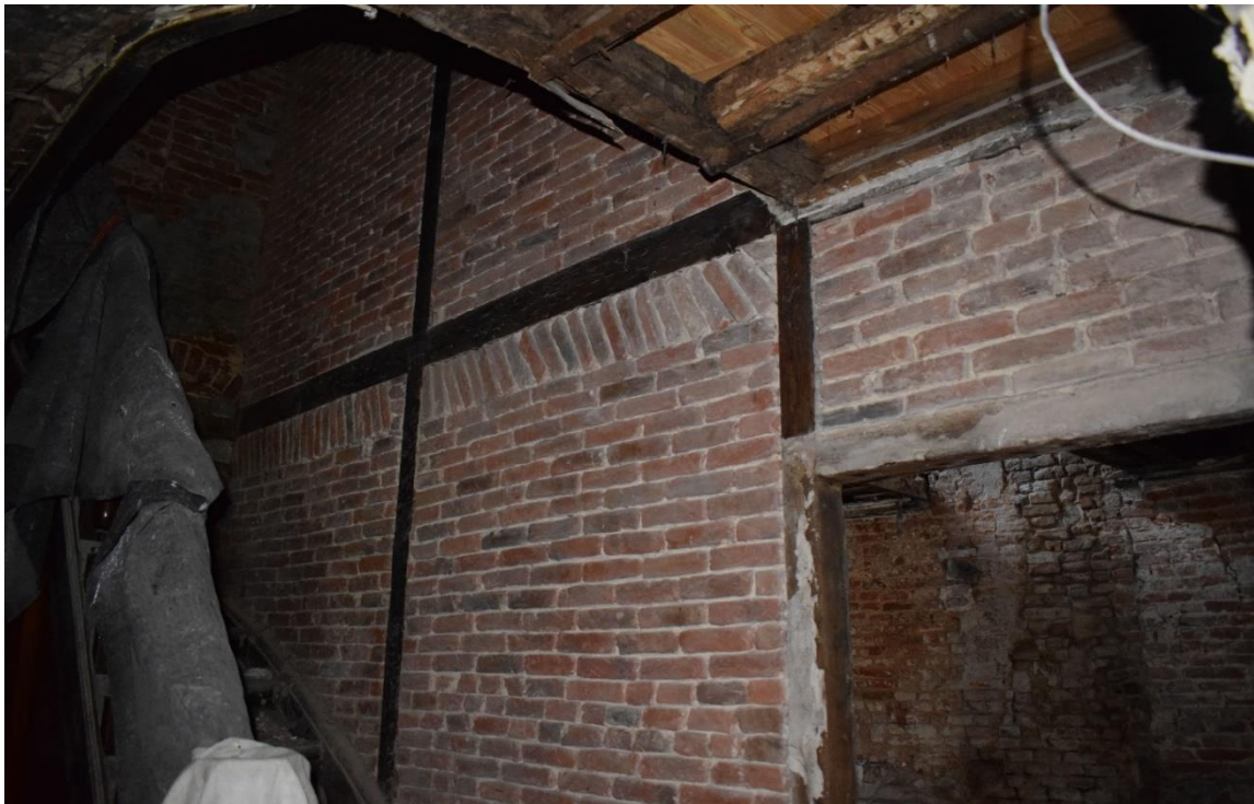
Fig. 66. Différence de traitement de la menuiserie du pan de bois, EA S0.2 MO, cliché de F. Van Boxem
