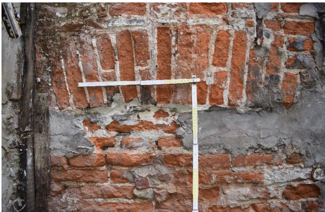
Fig. 223. Dégagement partiel de la couche de ciment, 02-05-23, EC S0.6 MO, cliché de F. Van Boxem
