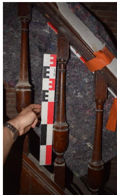
Fig. 70. Balustre en poire de la rampe d'escalier, EA S0.2 Equipement particulier, cliché de F. Van Boxem
