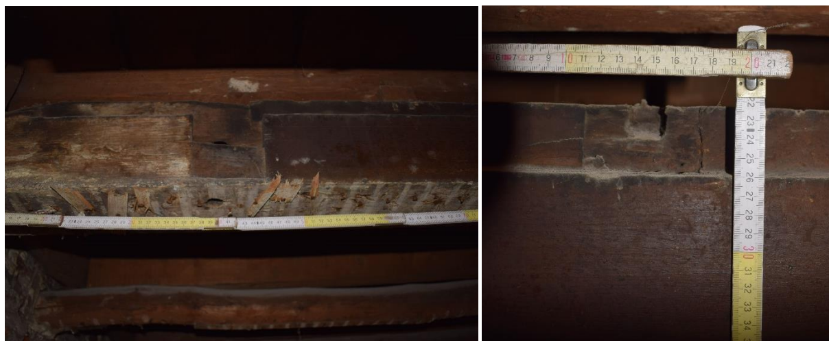
Fig. 193. Embrèvement de linteau (à gauche), gâche et battée (à droite), EB S0.4 Couvrement, clichés de F. Van Boxem
