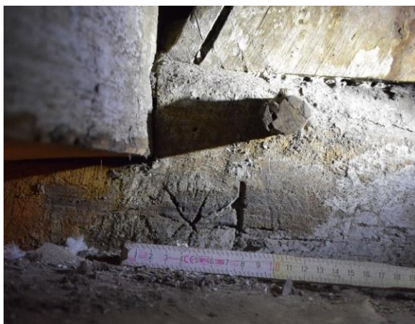
Fig. 172. Contremarque « A » sur la face nord côté est de l'entrait, EA S3.3, cliché de F. Van Boxem
