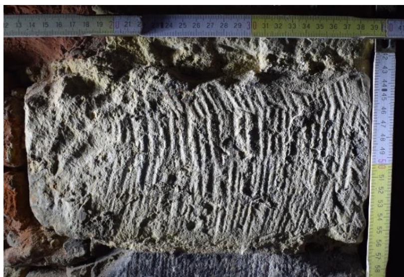
Fig. 182. Sillons profonds et taille de forme convexe (US 414), EB S0.4 MN, cliché de F. Van Boxem
