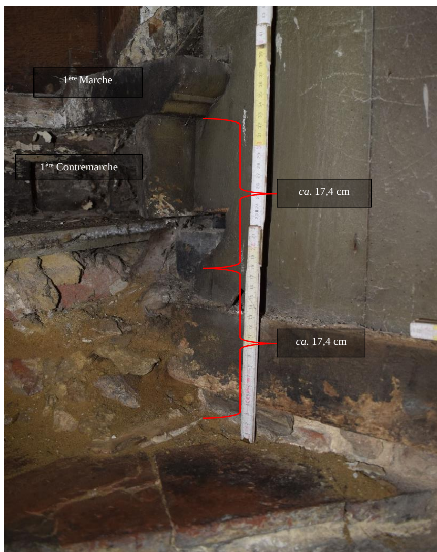
Fig. 78. Dégagement sous la marche de départ, cliché de F. Van Boxem
