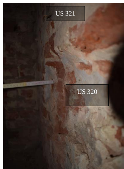
Fig. 61. Retrait de 3,5 cm de l'US 320 par rapport à l'US 321, EA S0.2 ME, cliché de F. Van Boxem
