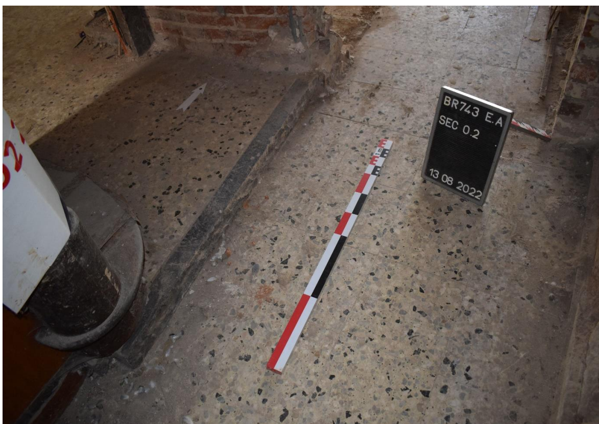
Fig. 68. Dalles de granito et zone surélevée au bas de l'escalier, EA S0.2 Revêtement de sol, cliché de F. Van Boxem
