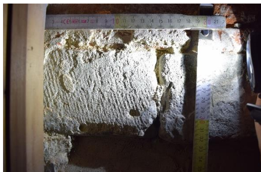
Fig. 199. Détail traces de taille (US 1203), EB S1.4 MN, cliché de F. Van Boxem
