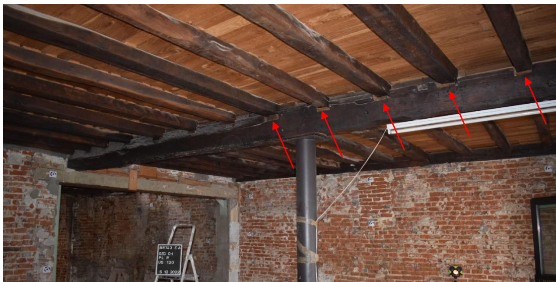
Fig. 56. Système de cales dans les assemblages et sur la face supérieure des solives, EA S0.1 plafond, cliché de F. Van Boxem
