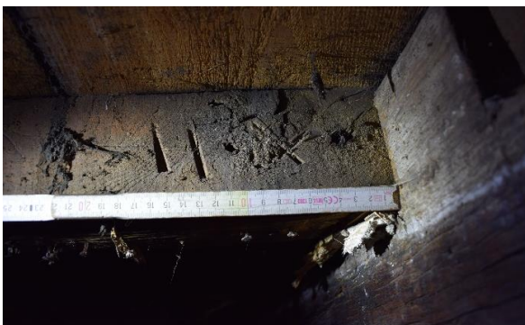
Fig. 114. Marque « IIX » solive n° 11 (US 1501), EA S1.3 Couvrement, cliché de F. Van Boxem
