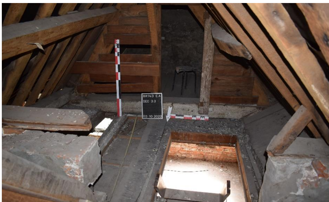
Fig. 167. Détail de la trappe de l'escalier escamotable, EA S3.2 Revêtement de sol, cliché de F. Van Boxem
