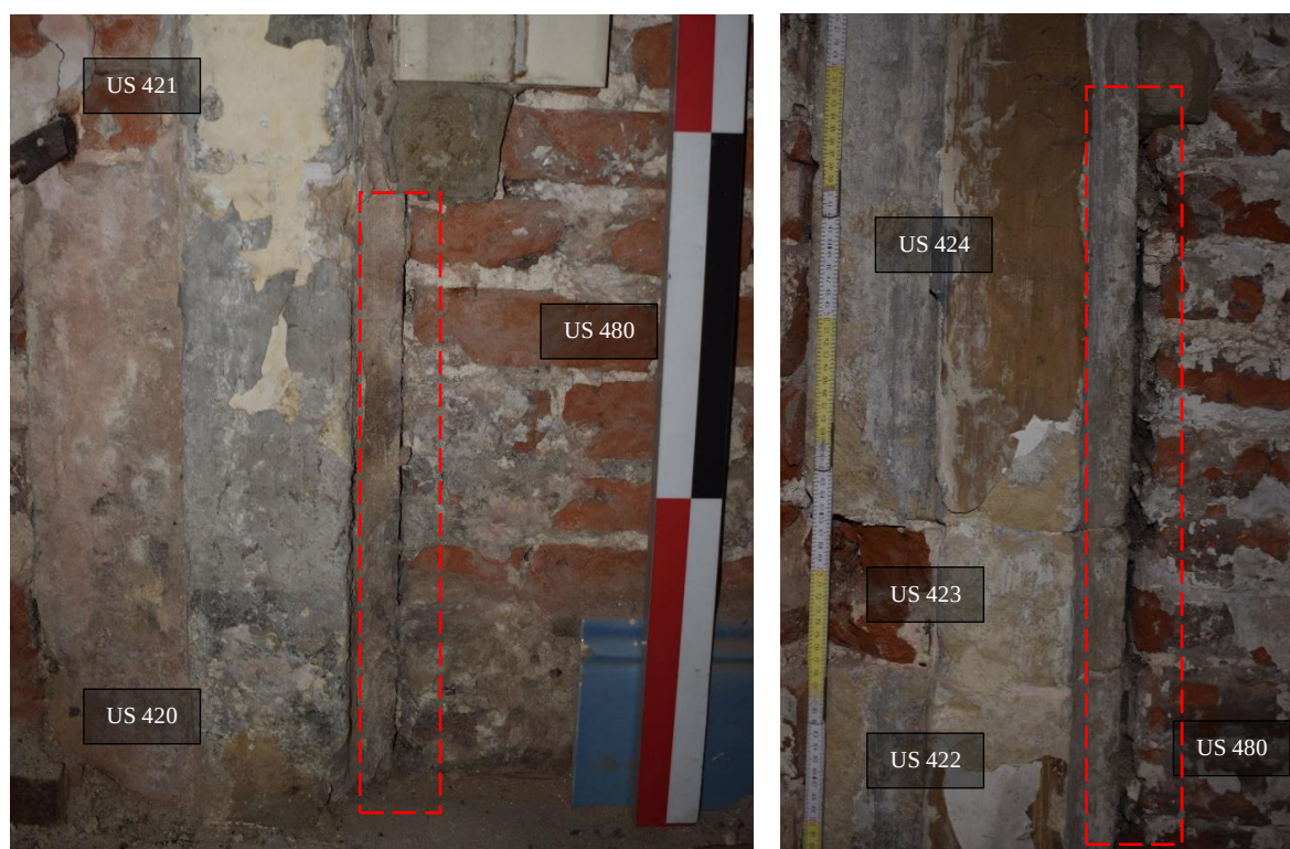
Fig. 185. Détail de l'interface entre le piédroit et l' US 480 , EB S0.4 ME, clichés de F. Van Boxem
