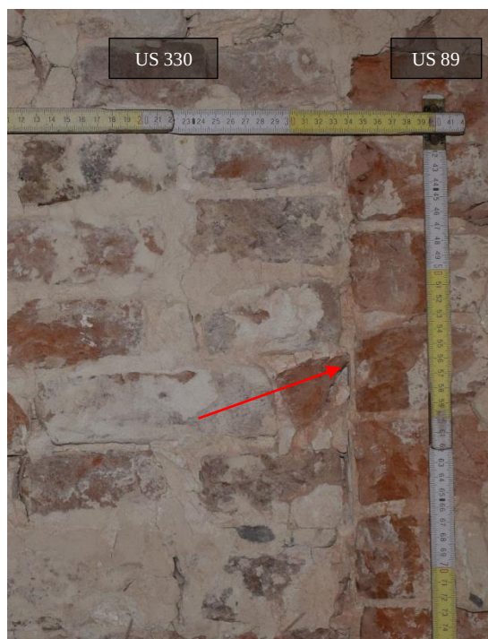
Fig. 60. Détail des couches de finition entre les US 330 et 89, EA S0.2 MN, cliché de F. Van Boxem
