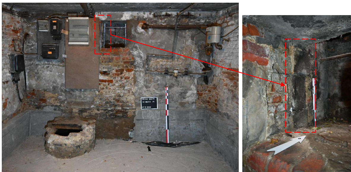
Fig. 40. Vue générale du mur nord (à gauche) et détail d'un piédroit avec battée en calcaire gréseux (à droite), EA S-1.1 MN, © Urban.brussels - ULB
