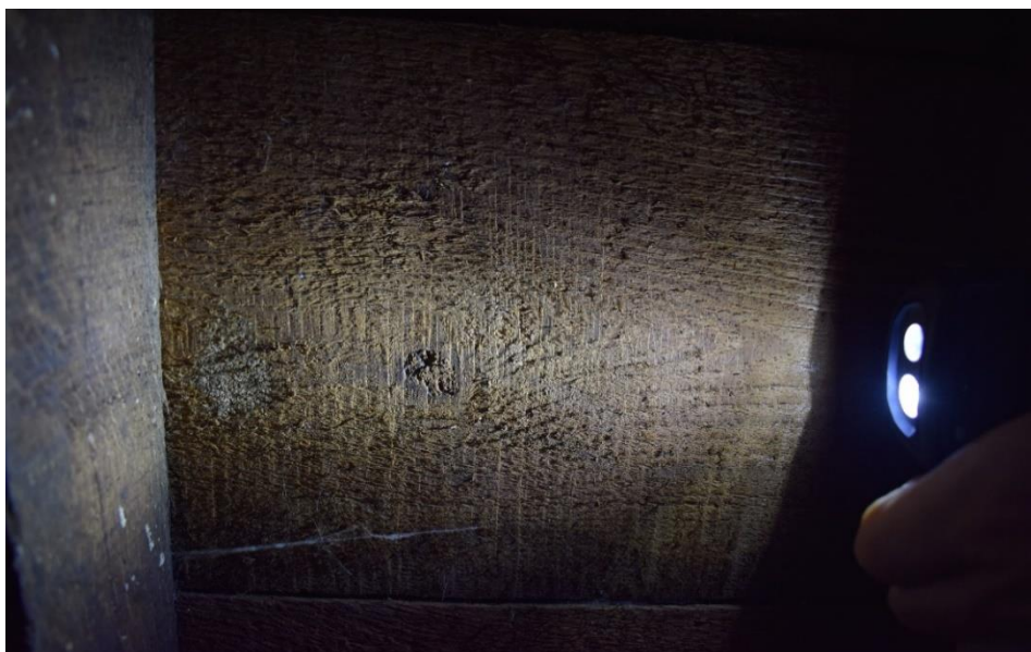
Fig. 90. Détail des traces de sciage des lames de plancher de l'US 601, EA S0.3 Couvrement, cliché de F. Van Boxem
