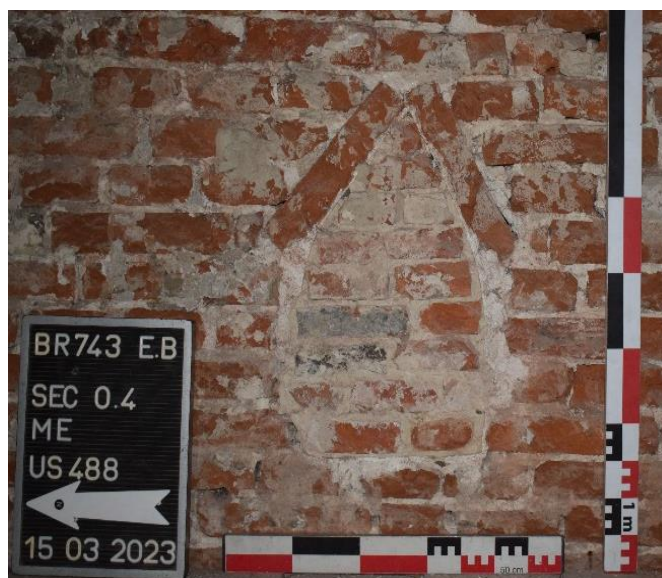
Fig. 186. Niche à mitre (US 488), EB S0.4 ME, cliché de F. Van Boxem
