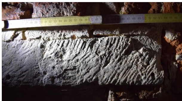
Fig. 198. Détail traces de taille (US 1202), EB S1.4 MN, cliché de F. Van Boxem
