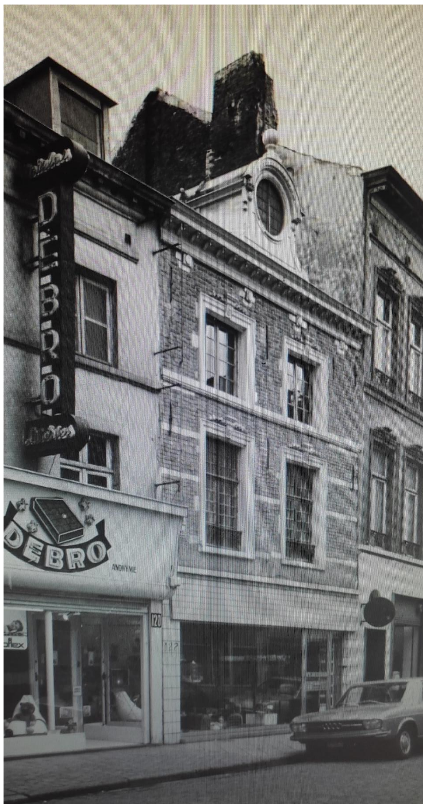
Fig. 20. Vue de la façade du n° 122, mars 1977, © AVB.
