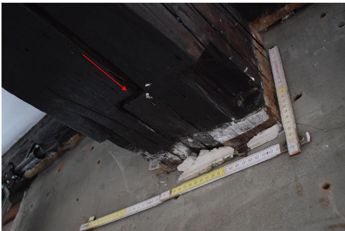
Fig. 97. Détail de la cavité rectangulaire située sur la face inférieure nord de l'US 1450, EA S1.1 Couvremet, cliché de F. Van Boxem
