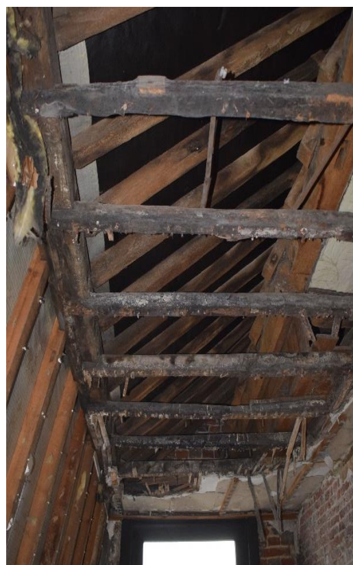
Fig. 138. Détail du faux plafond, EA S2.2 Couvrement, cliché de F. Van Boxem
