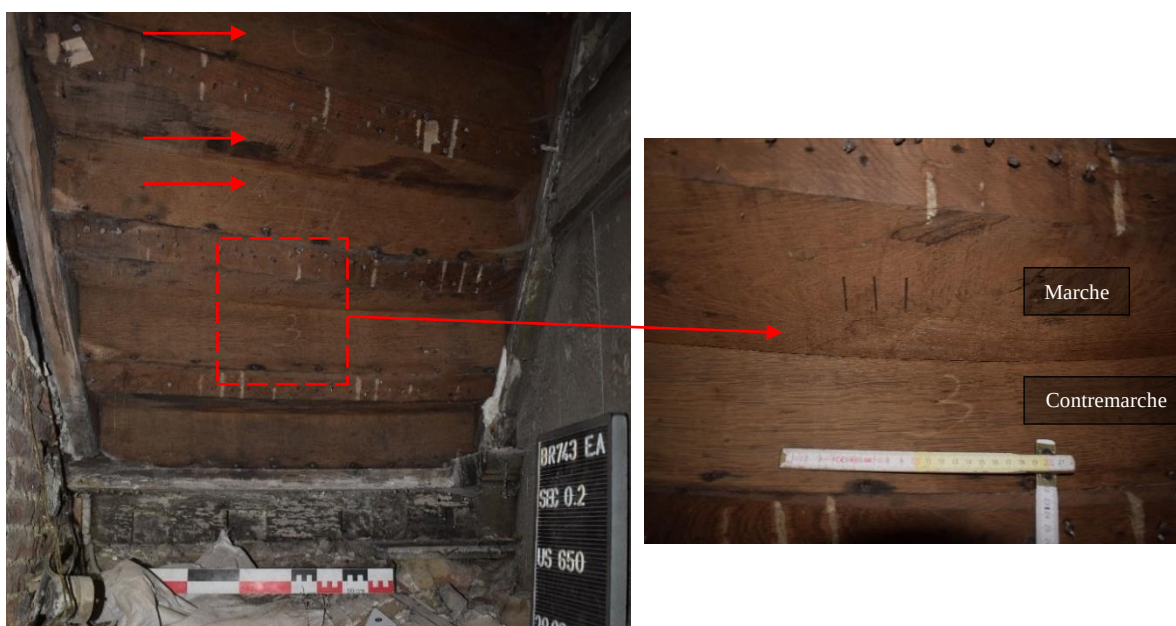
Fig. 75. Marques d'assemblage de marches et contremarches (à gauche), détail des marques des marches et contremarches n° 3 (à droite), clichés de F. Van Boxem
