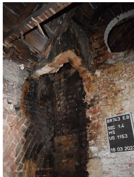
Fig. 203. Restant du coffre de cheminée, EB S1.4 ME, cliché de F. Van Boxem
