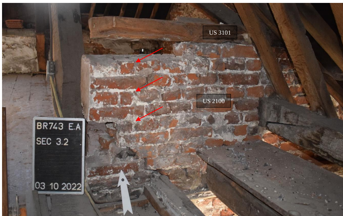
Fig. 163. Préparation de l'appareil de la maçonnerie avec des demi-boutisses sur l'US 2100, EA S3.2 MN, cliché de F. Van Boxem
