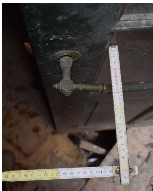
Fig. 218. Poignée béquille extérieure, EC S0.6 ME, cliché de F. Van Boxem
