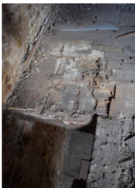
Fig. 147. Détail du revêtement de sol autour de la trémie, EA S2.3 Revêtement de sol, cliché de F. Van Boxem
