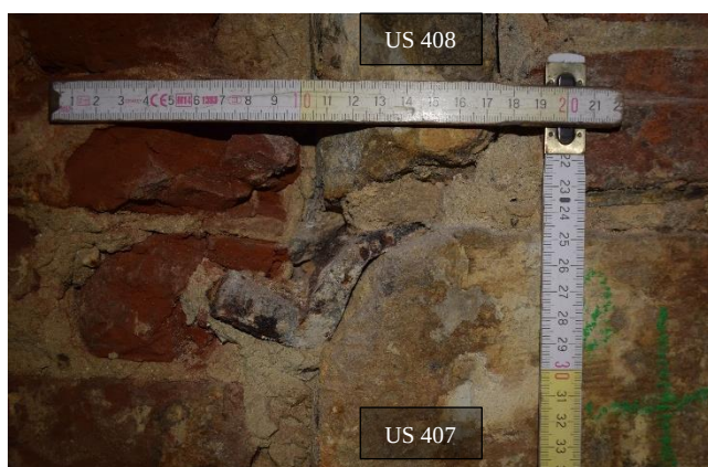
Fig. 176. Gond de section ronde, EB S0.4 MN, cliché de F. Van Boxem
