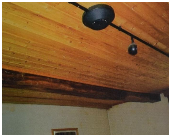
Fig. 28. Poutre maîtresse et faux-plafond du deuxième étage du bâtiment avant, 2004, © Urban.brussels.
