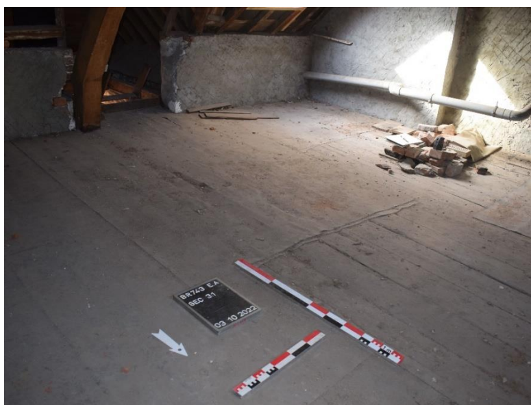
Fig. 161. Fragments de balatum cloué, EA S3.1 Revêtement de sol, cliché de F. Van Boxem
