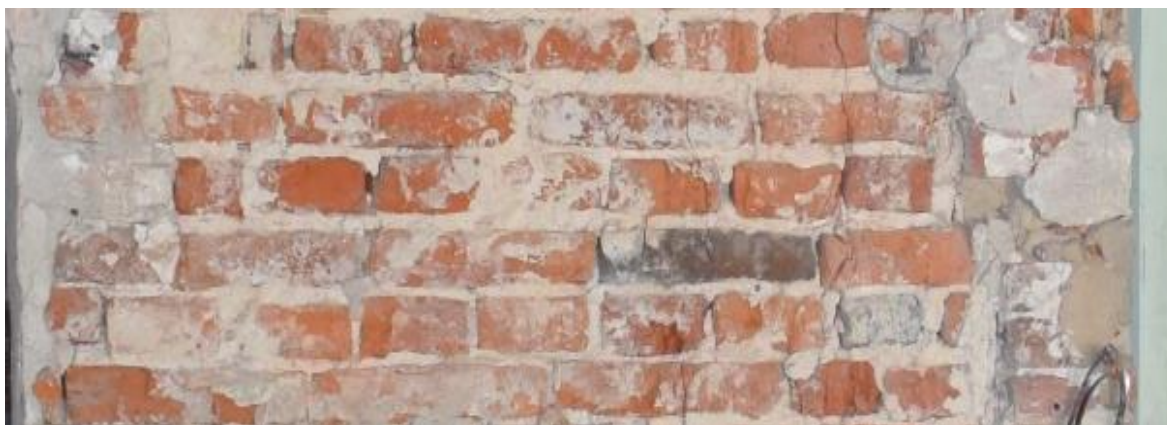
Fig. 48. Détail de l'appareil « vertical » alternant lits de panteresses et lits de boutisses, EA S0.1 MS, cliché de F. Van Boxem
