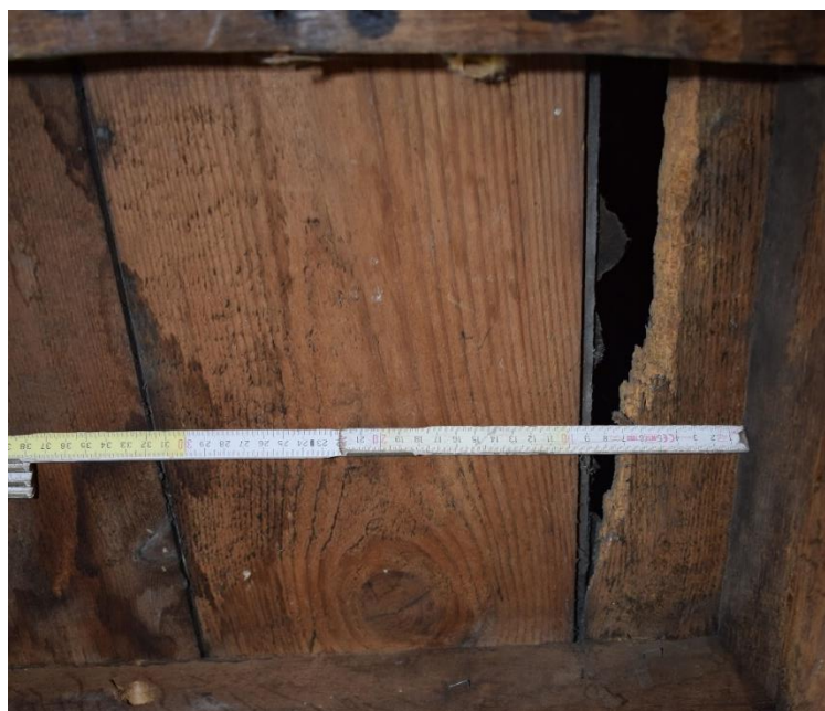
Fig. 124. Assemblage à mi-bois à feuillure en « S » (US 2203), EA S2.1 Couvrement, cliché de F. Van Boxem
