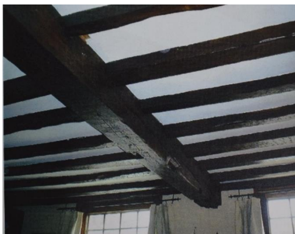
Fig. 27. Poutre maîtresse et solives apparentes du premier étage du bâtiment avant, 2004, © Urban.brussels.
