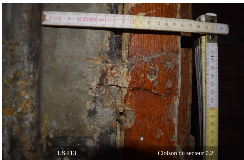
Fig. 179. Dernier élément métallique faisant le lien entre l'US 413 et la cloison de l'escalier, EB S0.4 MN, cliché de F. Van Boxem
