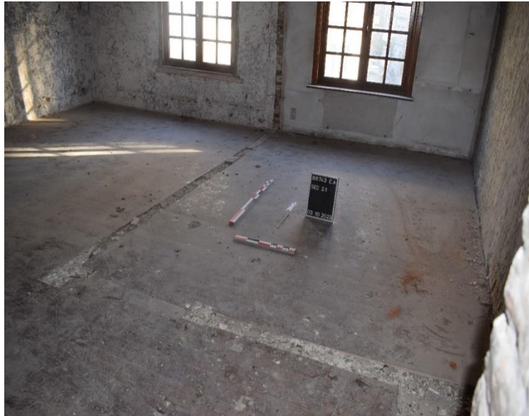
Fig. 127. Trace de l'ancien cloisonnement sur le revêtement de sol, EA S2.1, cliché de F. Van Boxem
