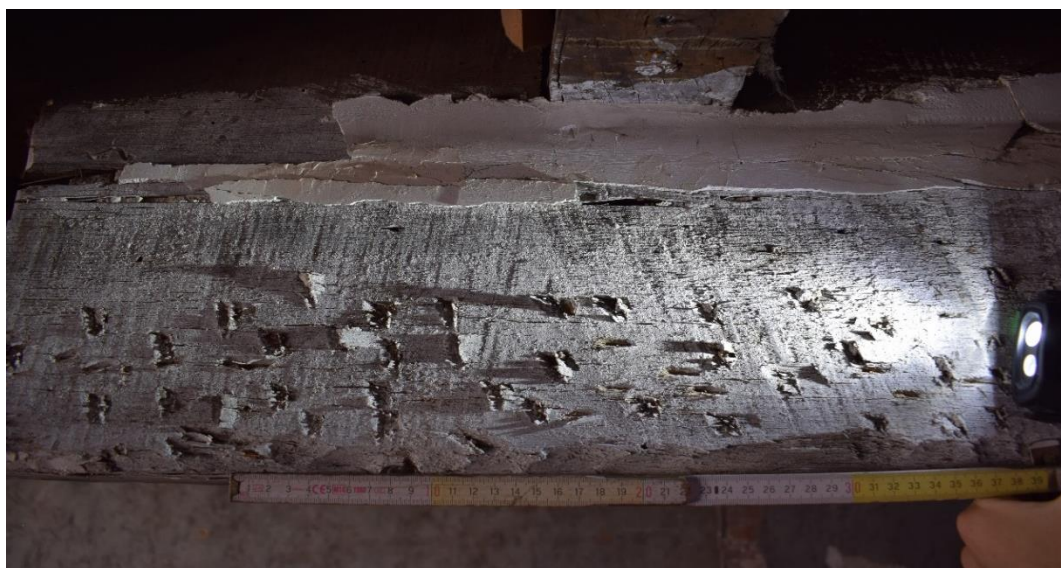
Fig. 122. « V » de sciage sous différentes finitions, face latérale est (US 2200), EA S2.1 Couvrement, cliché de F. Van Boxem
