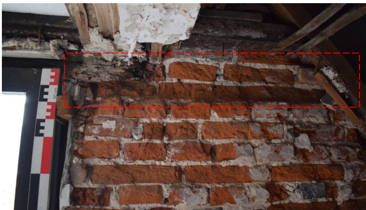
Fig. 143. Creusement de deux lits de briques et pièce de bois qui soutient la poutre (US 2064), EA S2.3 ME, cliché de F. Van Boxem
