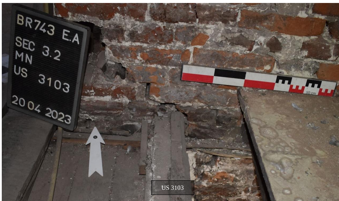
Fig. 166. Détail de l'encastrement de l'US 3103, EA S3.2 MN, cliché de F. Van Boxem
