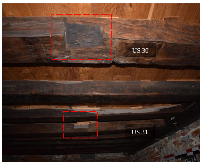
Fig. 55. Assemblages vides des US 30 et 31, EA S0.1 plafond, cliché de F. Van Boxem
