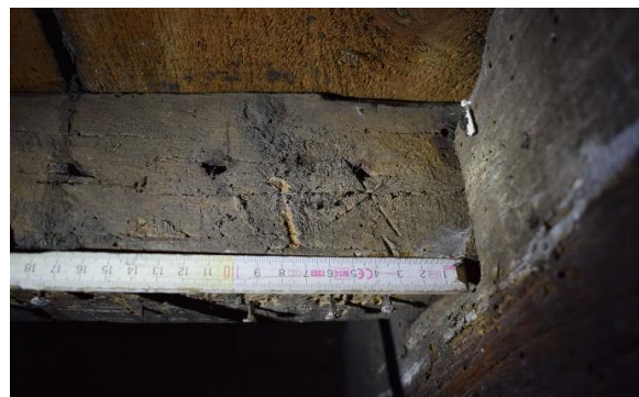
Fig. 115. Marque « IX » solive n° 13 (US 1501), EA S1.3 Couvrement, cliché de F. Van Boxem
