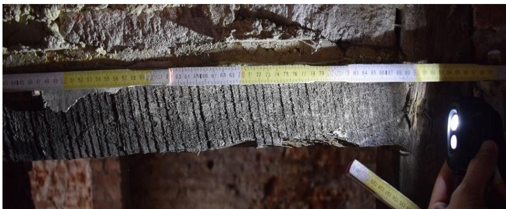
Fig. 64. Traces de sciage mécanique sur la face ouest du linteau, EA S0.3 ME, cliché de F. Van Boxem
