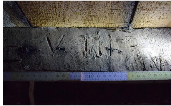
Fig. 111. Marque « VIII » solive n° 2 (US 1501), EA S1.3 Couvrement, cliché de F. Van Boxem
