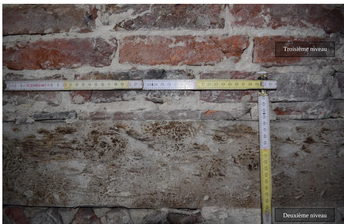
Fig. 135. Assise de carreaux de terre cuite architecturale, EA S2.2 MO, cliché de F. Van Boxem
