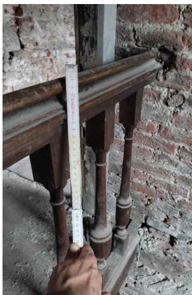
Fig. 71. Main courante avec un profil à gorge asymétrique, EA S2.2 Equipement particulier, cliché de F. Van Boxem
