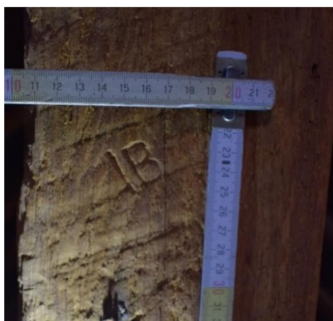
Fig. 155. Poinçon « IB » sur la face nord de la jambe de force sud, EA S3.1 Couvrement, cliché de F. Van Boxem
