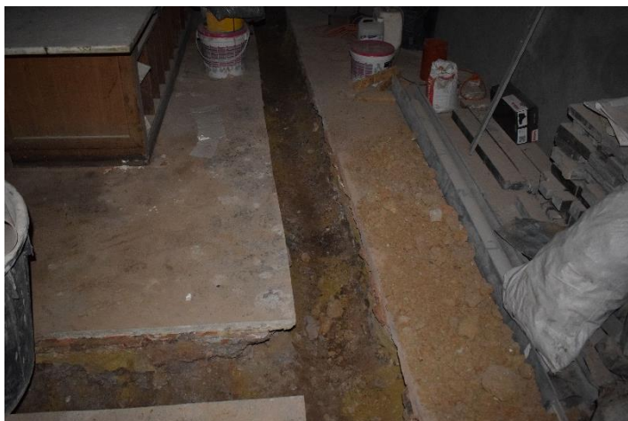
Fig. 227. Détail du revêtement de sol, EC S0.7 Revêtement de sol, cliché de F. Van Boxem
