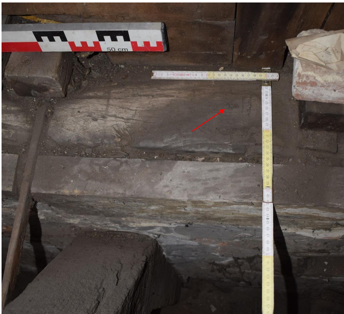
Fig. 160. Clou arraché sur la sablière du surcroît, EA S3.1 Couvrement, cliché de F. Van Boxem
