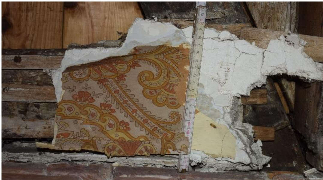
Fig. 106. Lattage et couches de finition (US 653), EA S1.2 Couvrement, cliché de F. Van Boxem
