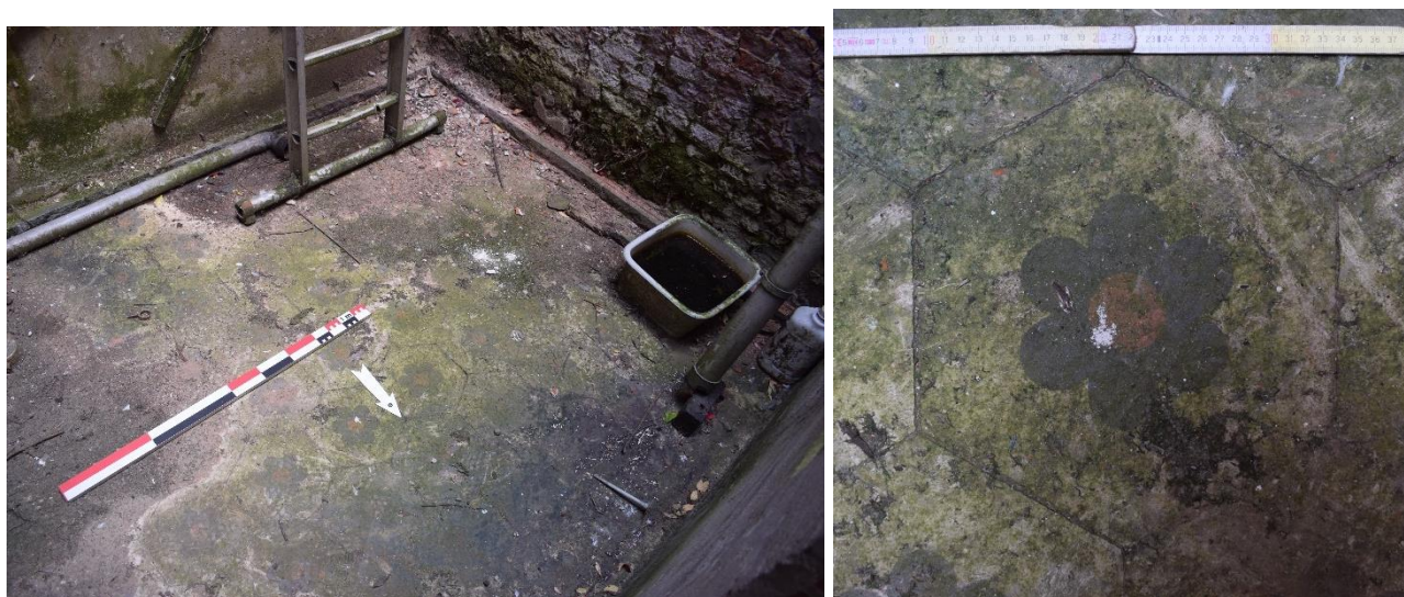
Fig. 224. Détail du revêtement de sol (US 523), EC S0.6 Revêtement de sol, clichés de F. Van Boxem
