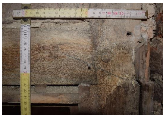
Fig. 102. Détail marque d'assemblage nord du linteau, EA S1.2 ME, cliché de F. Van Boxem
