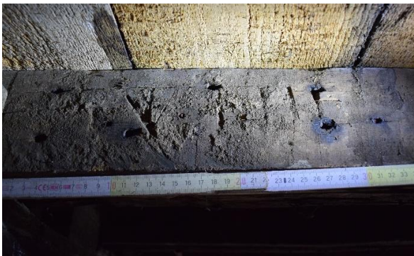
Fig. 112. Marque « VIII » solive n° 3 (US 1501), EA S1.3 Couvrement, cliché de F. Van Boxem
