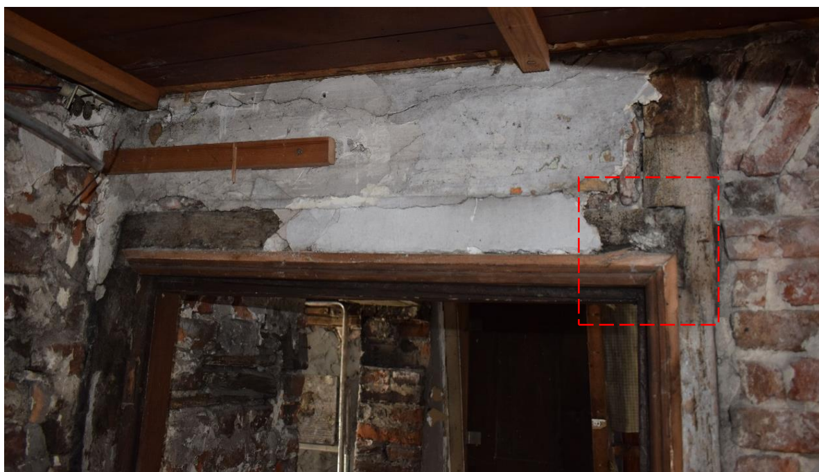
Fig. 136. Assemblage en sifflet du linteau, EA S2.3 ME, cliché de F. Van Boxem
