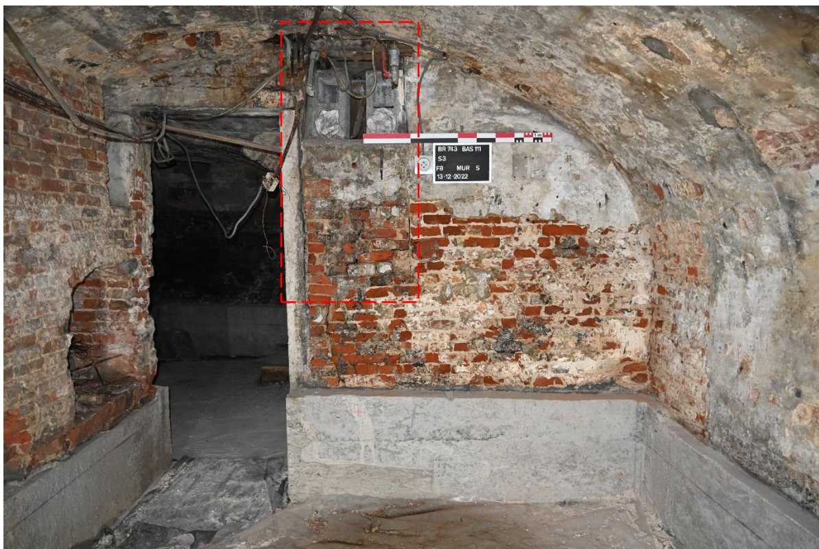
Fig. 41. Vue générale du mur sud dont la voûte est liaisonnée avec la maçonnerie ouest et avec trace d'un accès rebouché (encadré), EA S-1.4 MN, © Urban.brussels - ULB
