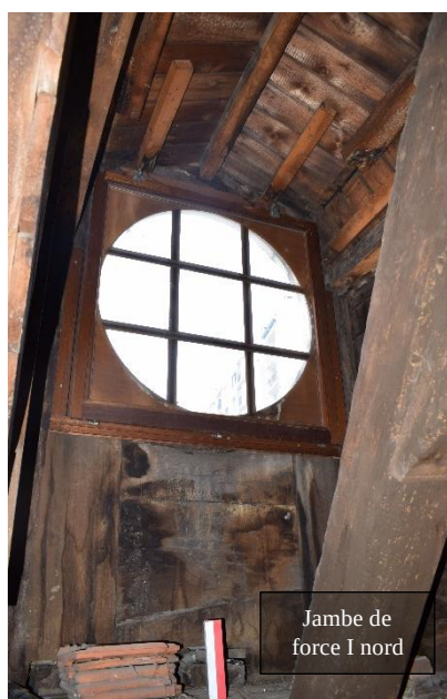
Fig. 34. Vue intérieure de la lucarne (US 3066) et des planches à sciage mécanique, EA S3.1 MN, cliché de F. Van Boxem
