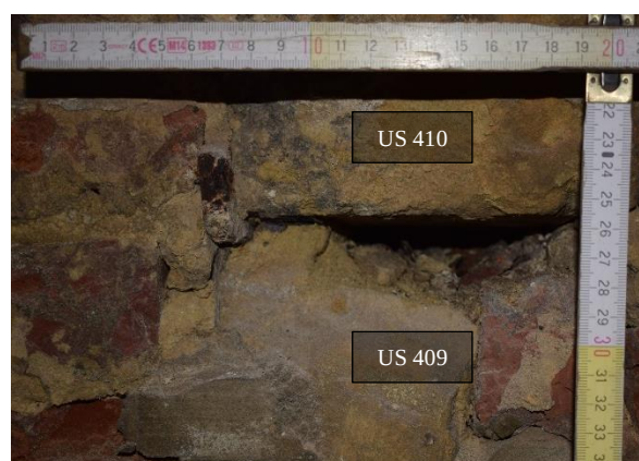
Fig. 177. Gond de section carrée, EB S0.4 MN, cliché de F. Van Boxem
