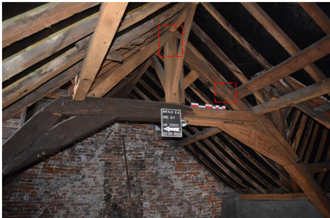
Fig. 154. Traces d'assemblages vides (US 3200) vues depuis l'ouest, EA S3.1 Couvrement, cliché de F. Van Boxem
