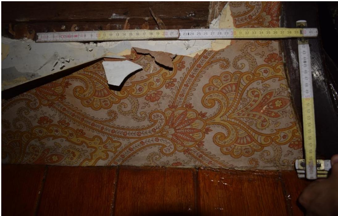
Fig. 69. Couches pigmentées et papier peint sur le plafond de l'escalier et cloison peinte en imitation « faux-bois » en partie inférieure, EA S0.2 Equipement particulier, cliché de F. Van Boxem
