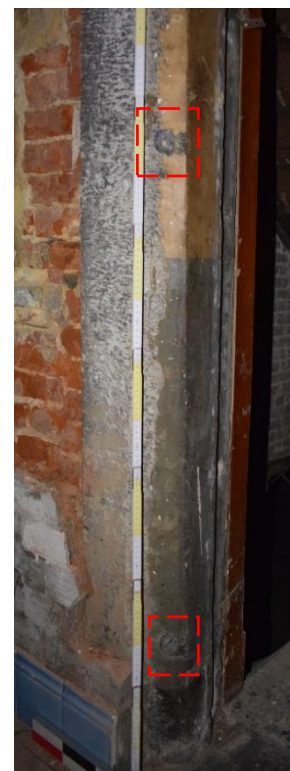
Fig. 180. Détails des ancrages du chanfrein de l'US 413, EB S0.4 MN, cliché de F. Van Boxem
