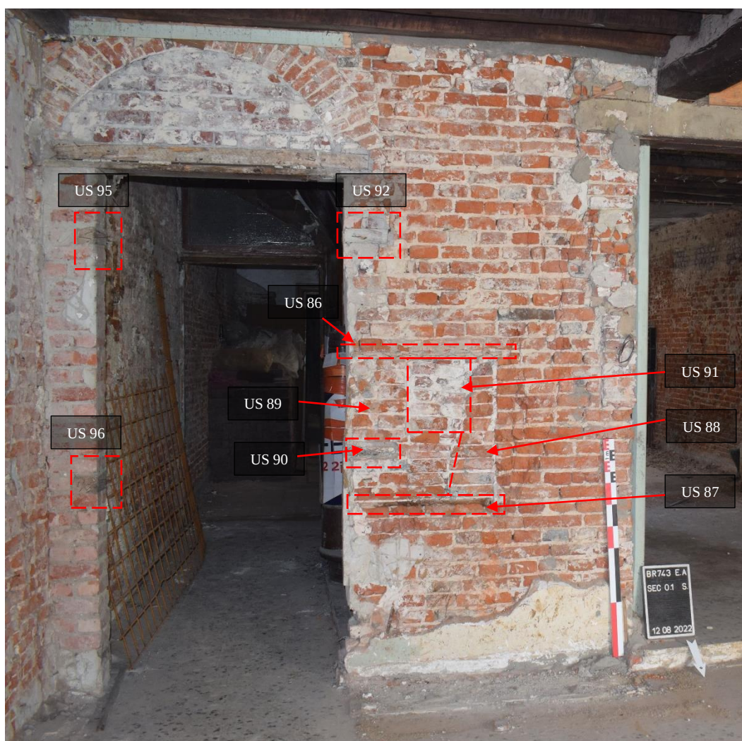
Fig. 49. Hypothèse des percements de la maçonnerie, EA S0.1 MS, cliché de F. Van Boxem
