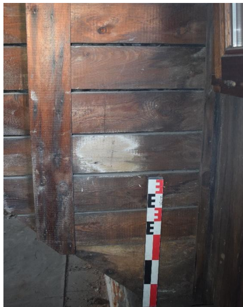
Fig. 158. Jouée ouest avec assemblages à joints plats et sciage mécanique, EA S3.1 Couvrement, cliché de F. Van Boxem
