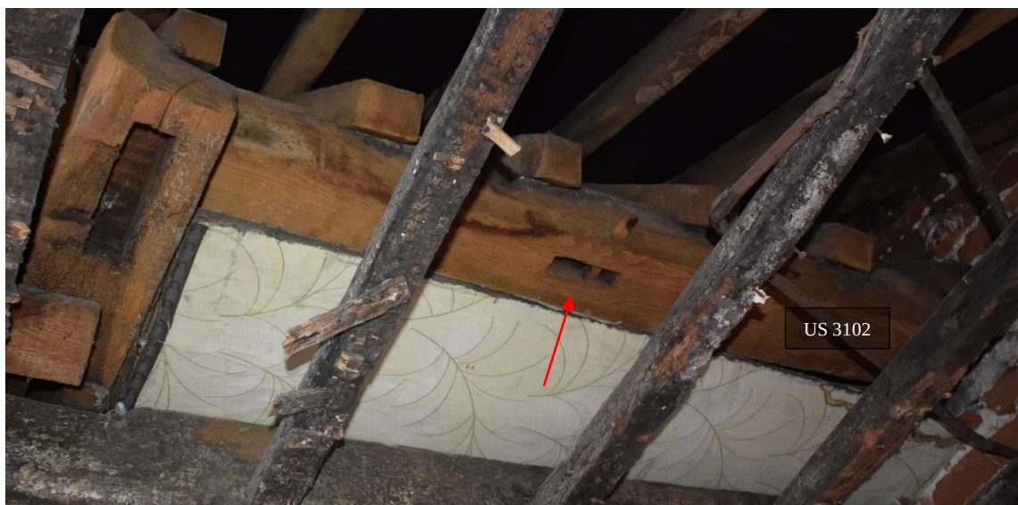
Fig. 165. Détail d'une mortaise vide au nord de la ferme de charpente du secteur 3.3, EA S3.2, cliché de F. Van Boxem
