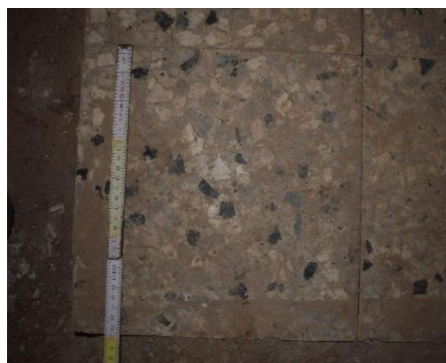
Fig. 58. Détail des dalles de granito (US 591), EA S0.1 Revêtement de sol, cliché de F. Van Boxem
