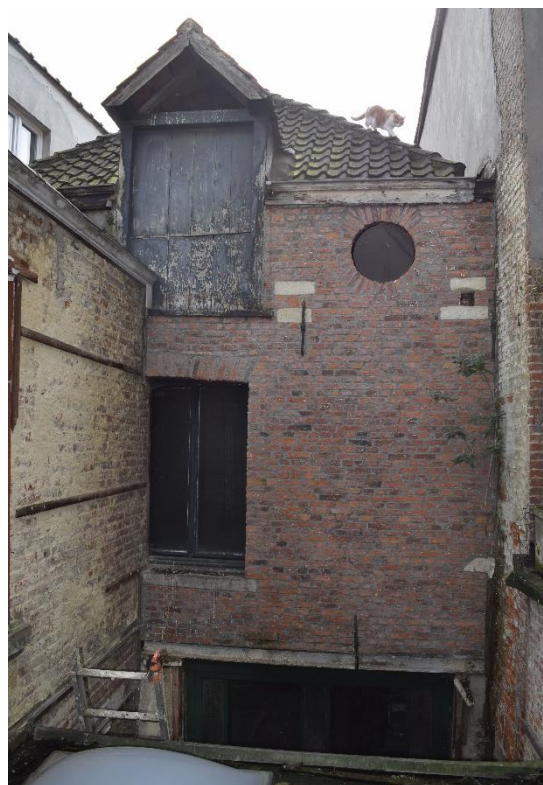
Fig. 225. Vue de la façade antérieure, rez-de-chaussée (ci-dessus) et des parties supérieure (à droite), ED façade antérieure, clichés de F. Van Boxem
