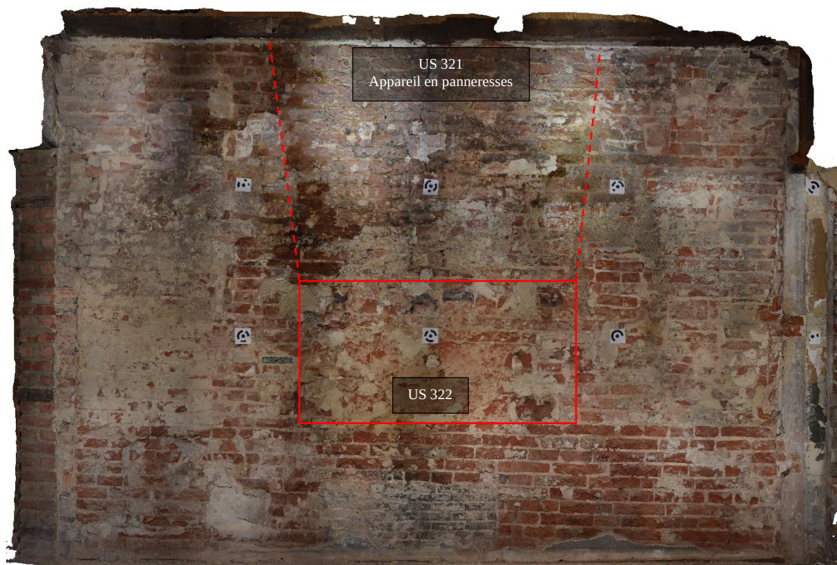
Fig. 63. Hypothèse du fait d'une cheminée, EA S0.2 ME, photogrammétrie de F. Van Boxem
