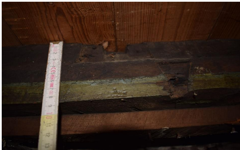
Fig. 107. Encoches en queue d'aronde et bande picturale de la solive n° 10 (US 655), EA S1.2 Couvrement, cliché de F. Van Boxem
