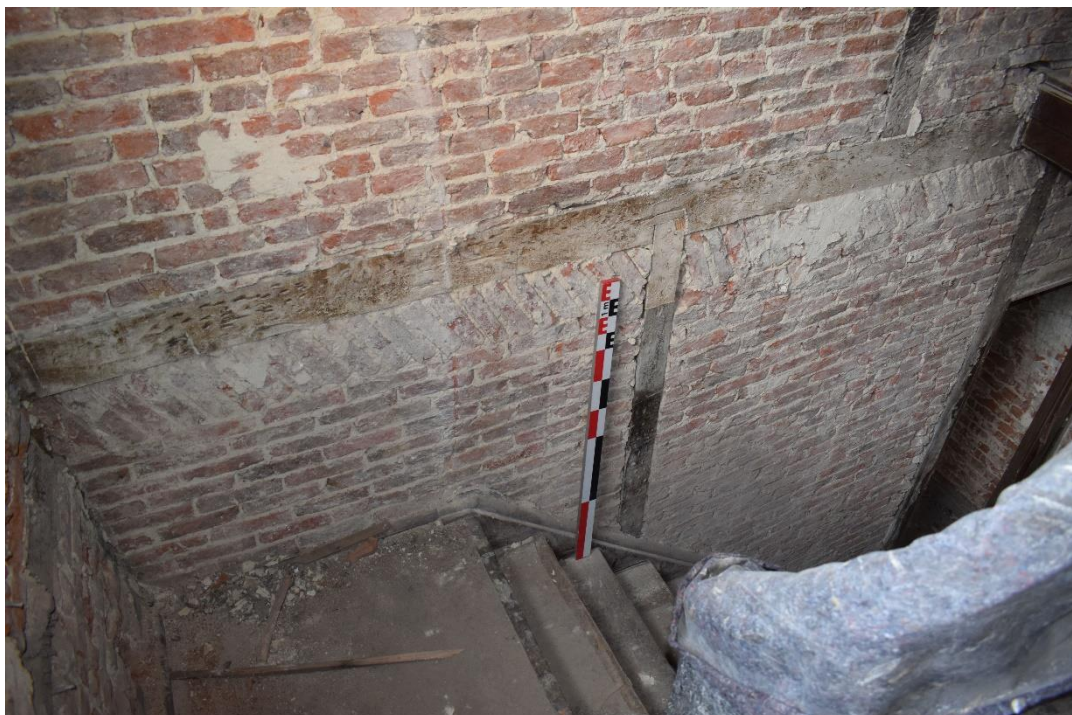
Fig. 103. Détail des finitions de l'interface orientale du pan de bois dans les S1.2 et 2.2, EA S1.2. 2.2 MF. cliché de F. Van Boxem
