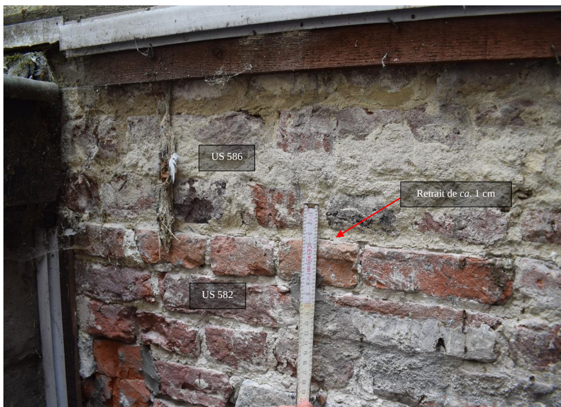
Fig. 220. Retrait de l'US 586 par rapport à l'US 582, EC S0.6 ME, cliché de F. Van Boxem
