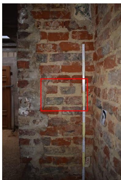
Fig. 80. Traitement de la maçonnerie depuis secteur 0.3, EA S0.3 MS, cliché de F. Van Boxem
