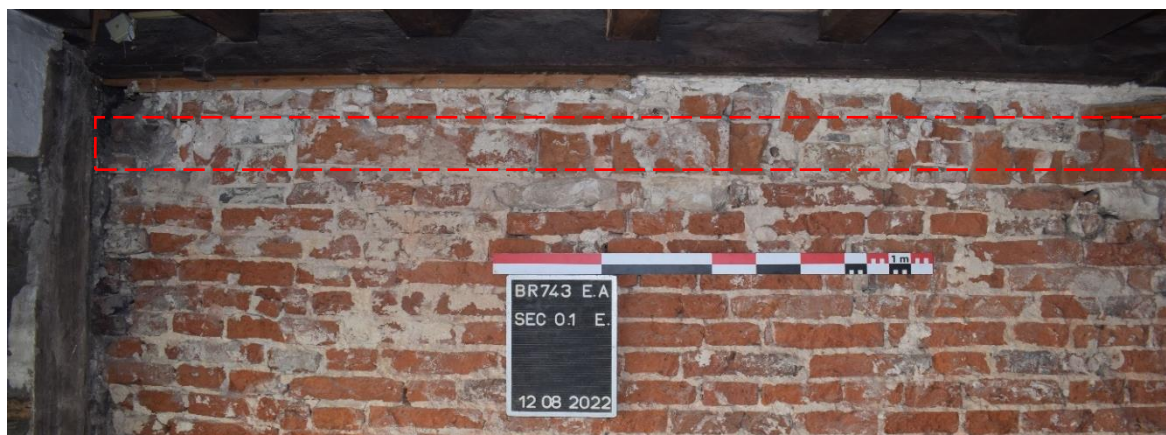
Fig. 45. Détail de l'US 56 recouverte par l'US 57 (encadrée en rouge), l'ensemble étant soutenu par des éléments lithiques (US 51, 52, 53, 54, 55), EA S0.1 ME, cliché de F. Van Boxem
