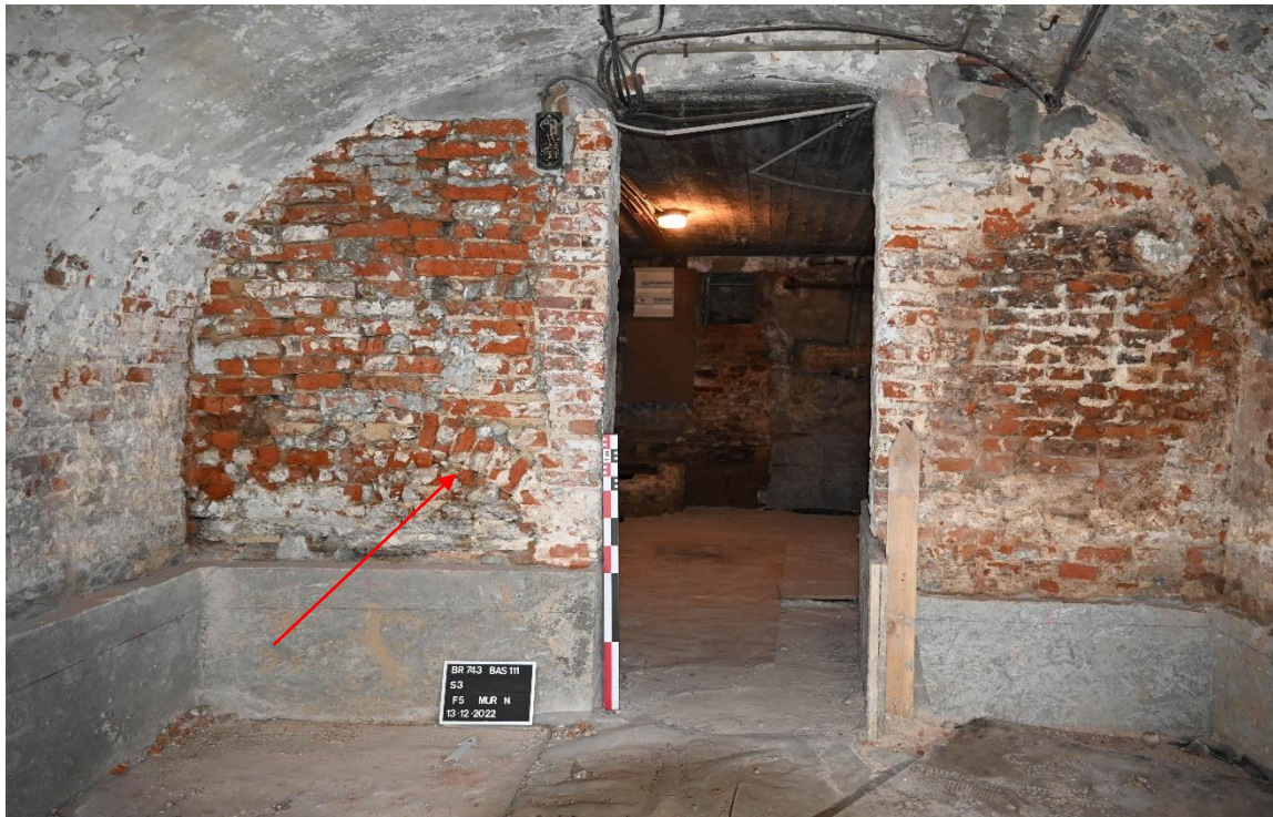
Fig. 39. Vue générale du mur nord comprenant à l’ouest un segment d’arc (indiqué par la flèche), EA S-1.4 MN, © Urban.brussels - ULB
