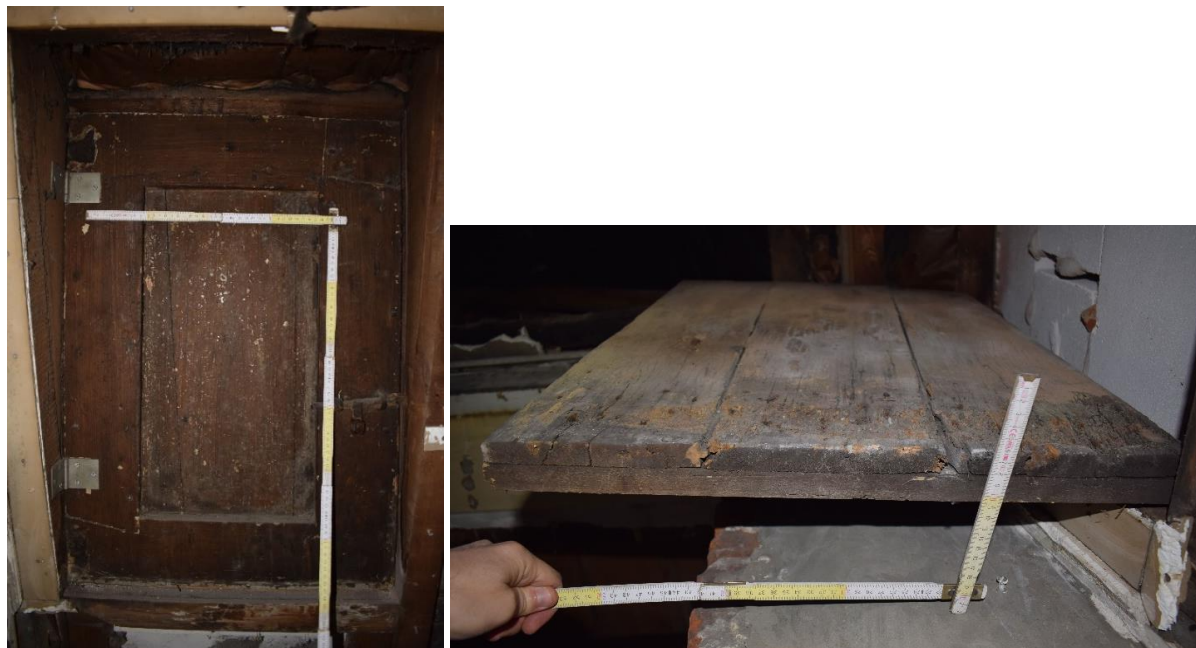
Fig. 139. Lucarne et détail d'assemblage des planches extérieures (vues depuis leurs faces inférieures), EA S2.2 Couvrement, clichés de F. Van Boxem
