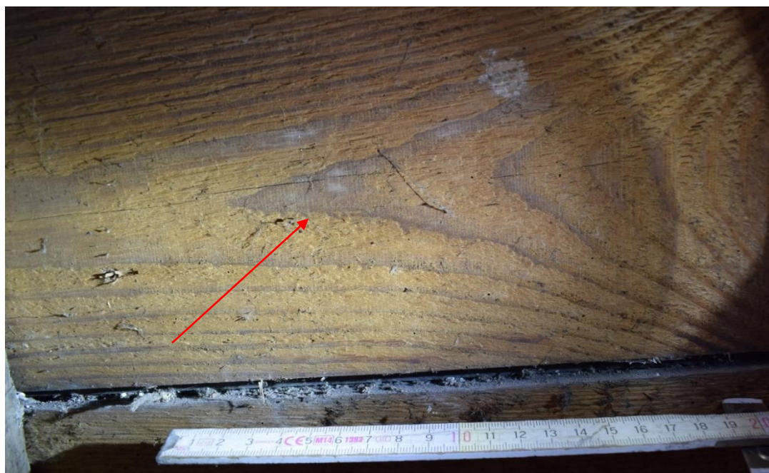
Fig. 125. Traces de sciage (US 2203), EA S2.1 Couvrement, cliché de F. Van Boxem
