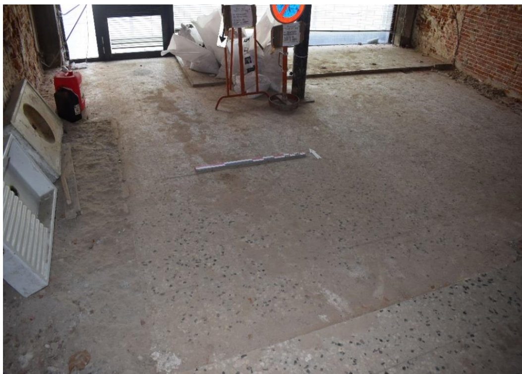
Fig. 59. US 591, EA S0.1 Revêtement de sol, cliché de F. Van Boxem
