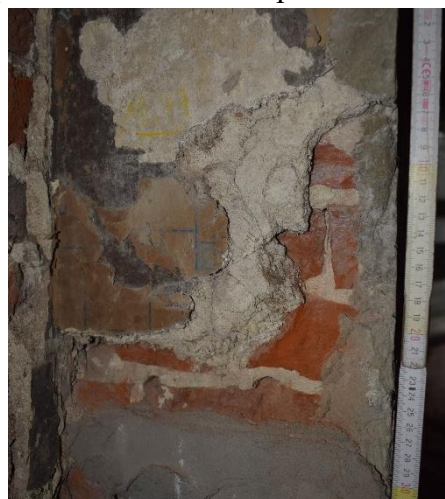
Fig. 50. Détail de l' US 104 , EA S0.3 MN, cliché de F. Van Boxem
