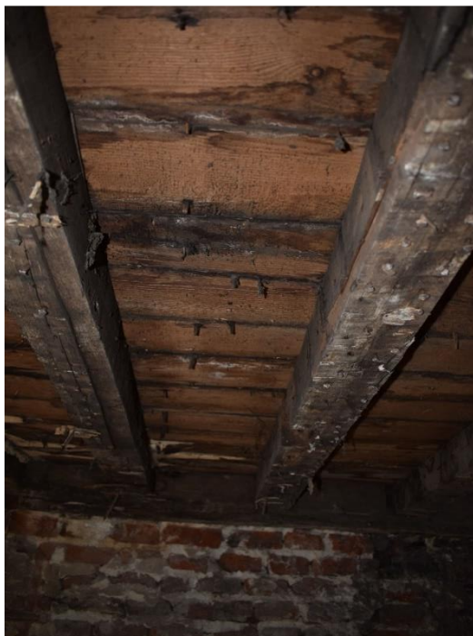
Fig. 118. Alignement de fiches en bois (US 1502), EA S1.3 Couvrement, cliché de F. Van Boxem
