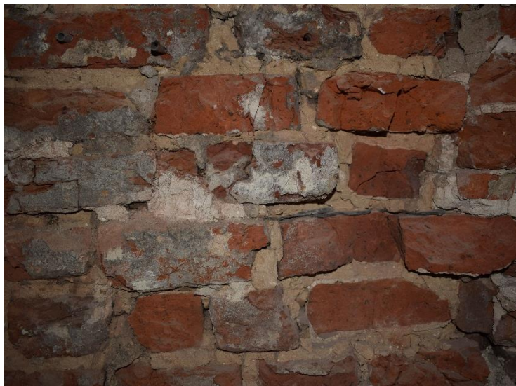
Fig. 52. Détail de l'US 23 avec des briques de remploi, cliché de F. Van Boxem
