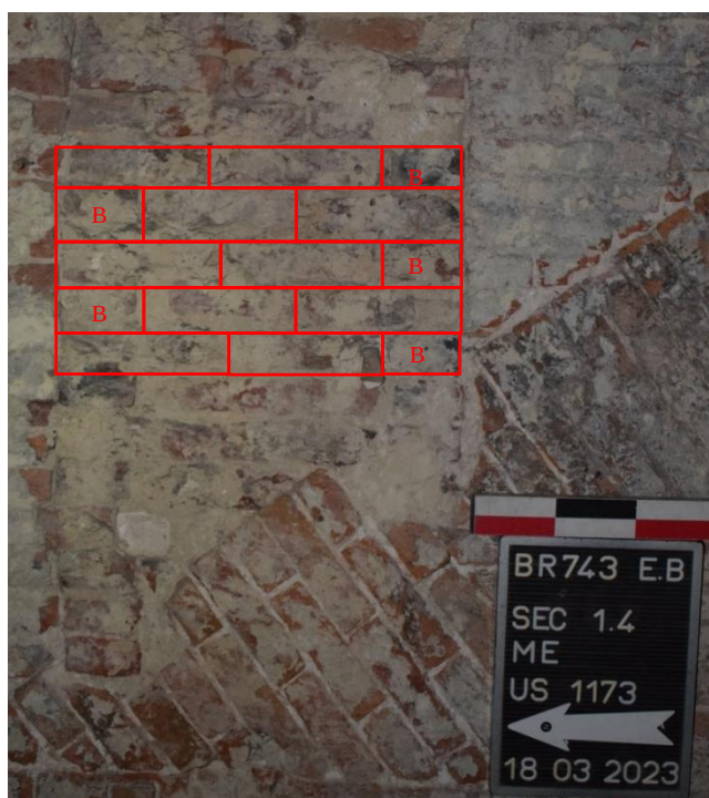
Fig. 239. Détail de l'appareil de l'US 1173, EB S1.4 ME, cliché de F. Van Boxem
