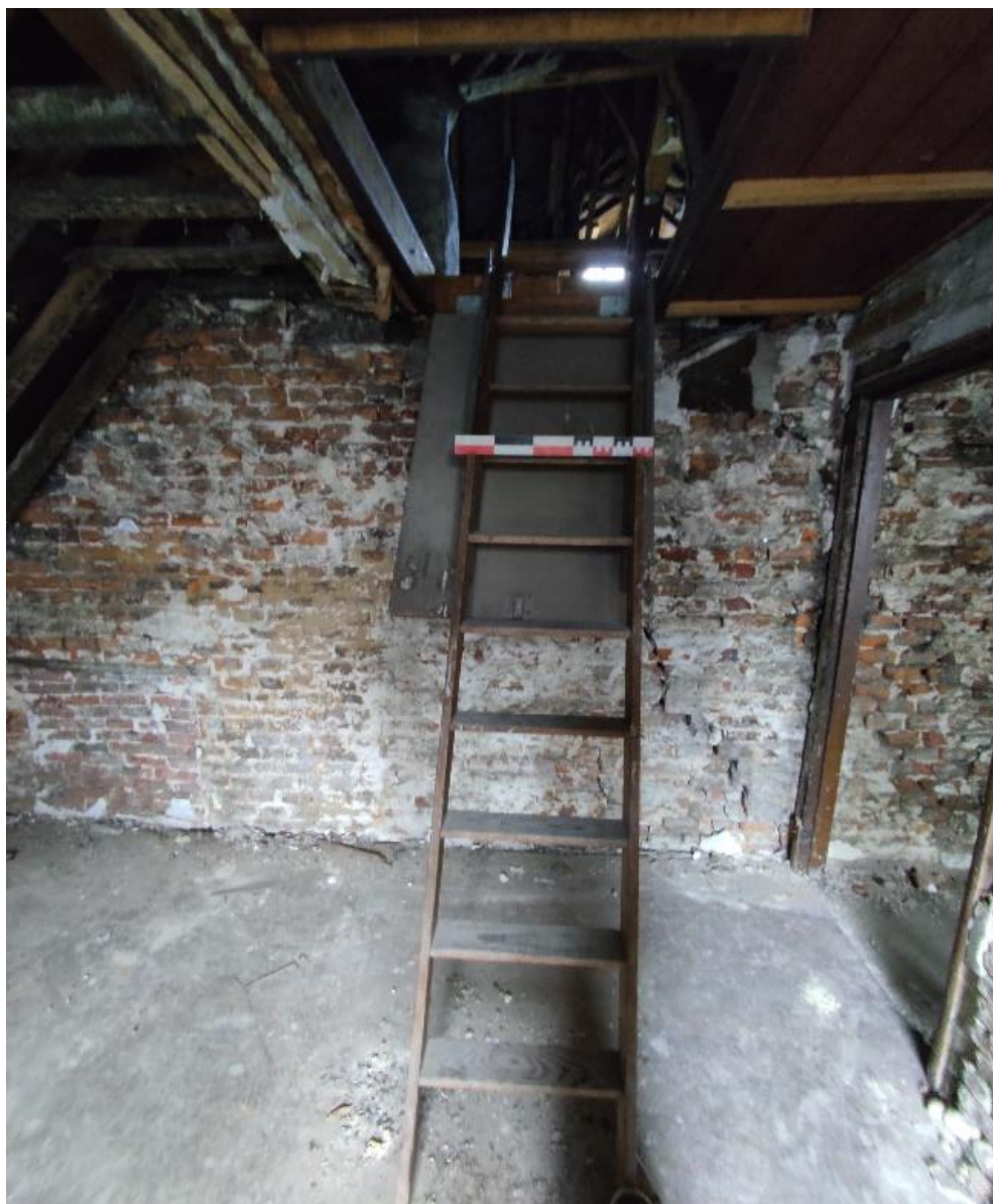
Fig. 168. Escalier escamotable menant au secteur 3.2, EA S3.2 Revêtement de sol, cliché de F. Van Boxem
