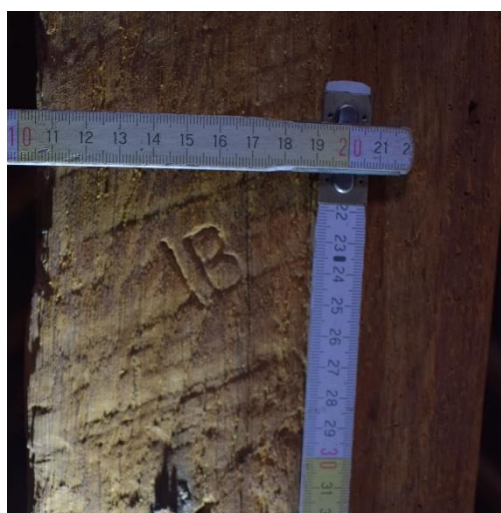
Fig. 237. Poinçon « IB » sur la face nord de la jambe de force sud, EA S3.1 Couvremet, cliché de F. Van Boxem
