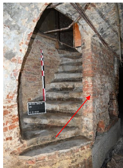
Fig. 42. Vue du nouvel escalier et du mur bahut (indiqué par la flèche) qui viennent interrompre la voûte du secteur -1.3, EA S-1.3, © Urban.brussels - ULB
