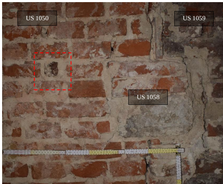
Fig. 94. Intégration d'un fragment de brique (encadrée par des tirets) dans l' US 1050 afin de préparer la mise en place de l'agrafe ( US 1058 ), EA S1.1 ME, cliché de F. Van Boxem
