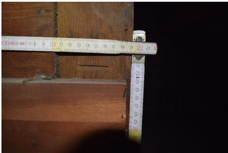
Fig. 171. Marque « I » sur la face nord du poinçon, EA S3.3, cliché de F. Van Boxem
