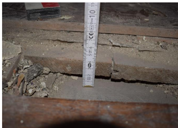
Fig. 129. Détail de l'assemblage à rainure et à languette, EA S2.1, cliché de F. Van Boxem
