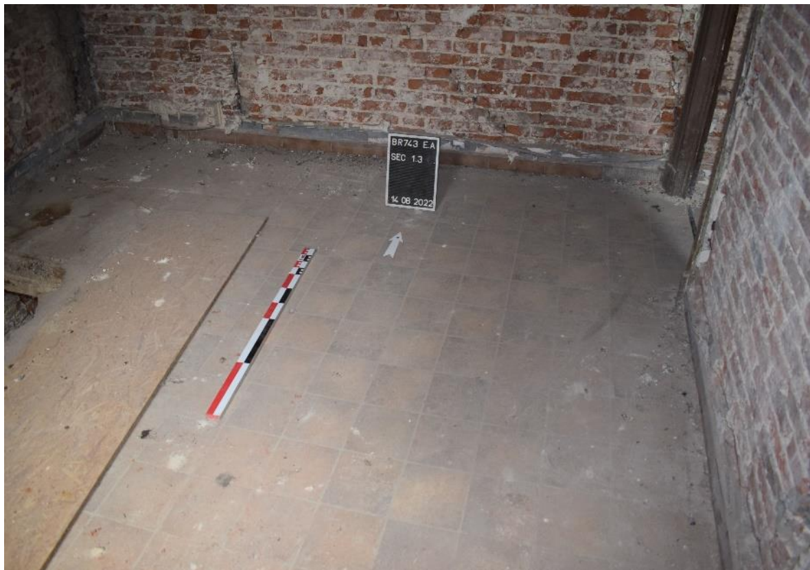
Fig. 120. Balatum imitant des carreaux, EA S1.3 Revêtement de sol, cliché de F. Van Boxem
