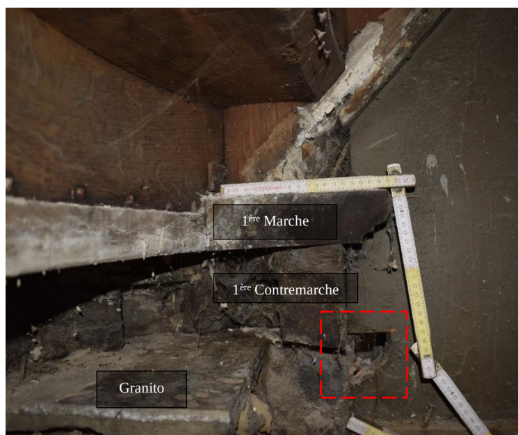
Fig. 76. Entaille triangulaire de la cloison sous la première marche (encadrée), cliché de F. Van Boxem
