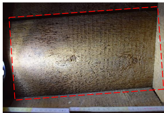
Fig. 191. Traces de sciage des lames de plancher, EB S0.4 Couvrement, cliché de F. Van Boxem
