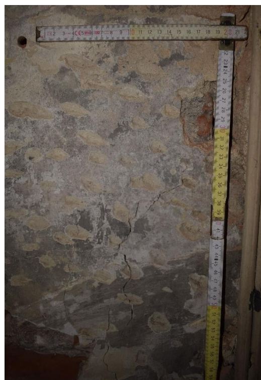
Fig. 197. Détail enduit entaillé (US 1200), EB S1.4 MN, cliché de F. Van Boxem
