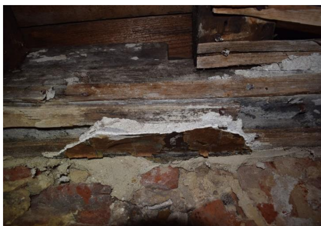
Fig. 88. Restant des lattes, de l'enduit et du papier peint sous la lambourde sud (n° 14), EA S0.3, cliché de F. Van Boxem
