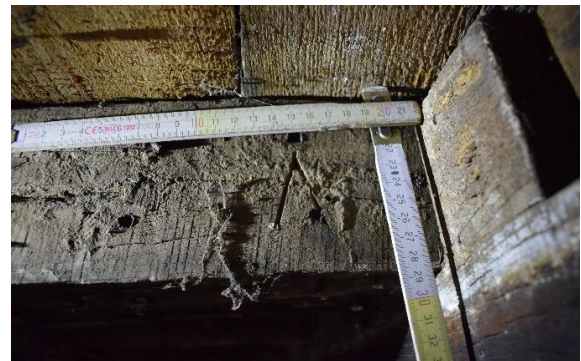
Fig. 113. Marque « Λ » solive n° 4 (US 1501), EA S1.3 Couvrement, cliché de F. Van Boxem
