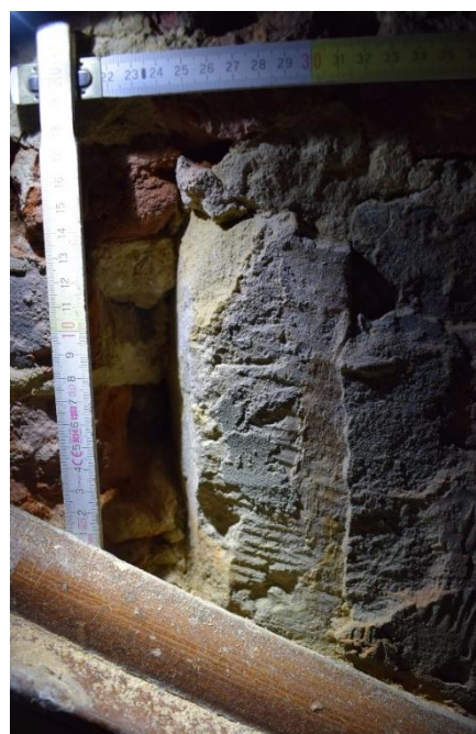
Fig. 100. Détail de l'interface nord de l' US 411 , EA S1.2 MS, cliché de F. Van Boxem
