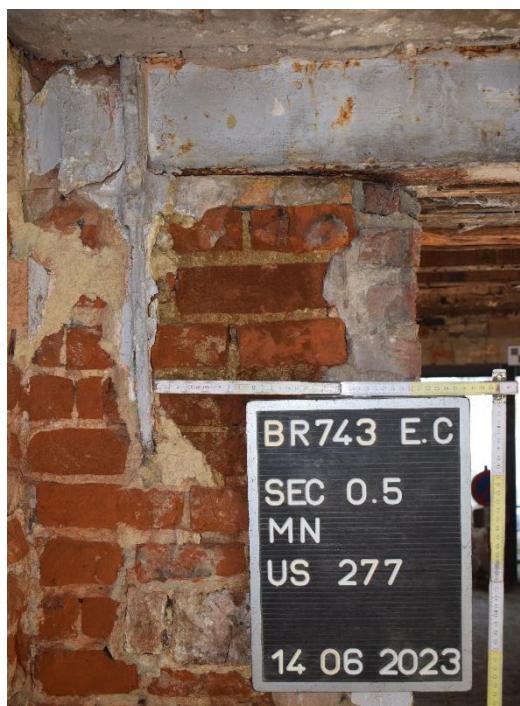
Fig. 209 Détail des finitions de l'ancre (US 277) et de la poutrelle, EC S0.5 MN, cliché de F. Van Boxem
