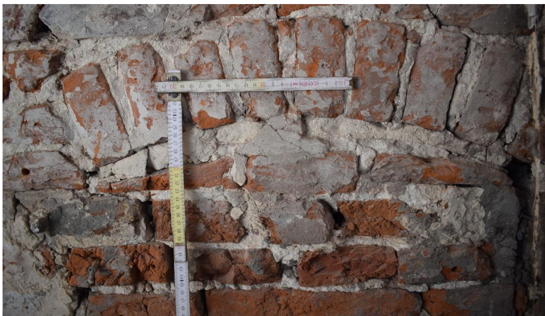
Fig. 134. Détail intrados de l'arc de décharge occidental, EA S2.2 MS, cliché de F. Van Boxem
