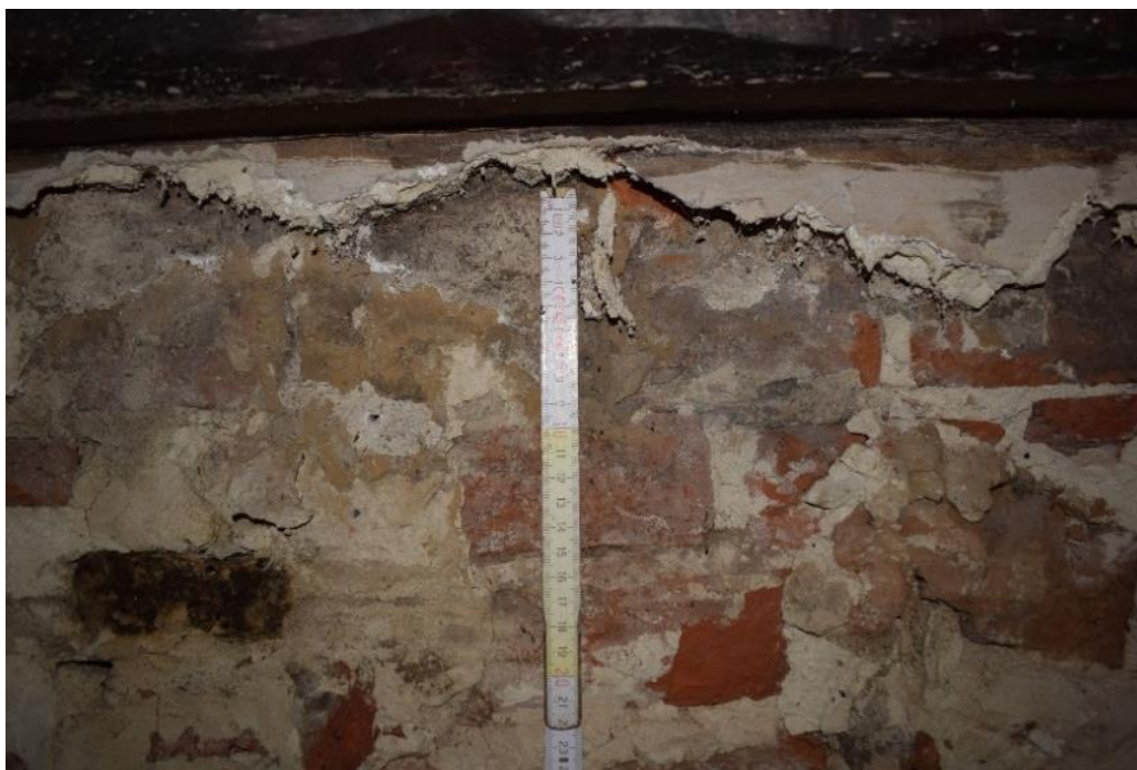
Fig. 92. Détail des couches de finition de l'US 1050, EA S1.1 ME, cliché de F. Van Boxem
