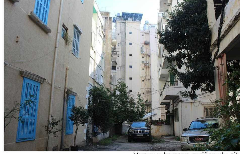
Vue sur la cour arriere du site
