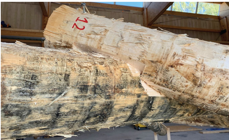
Figure 88 : Emboîtement de deux troncs lors du montage
