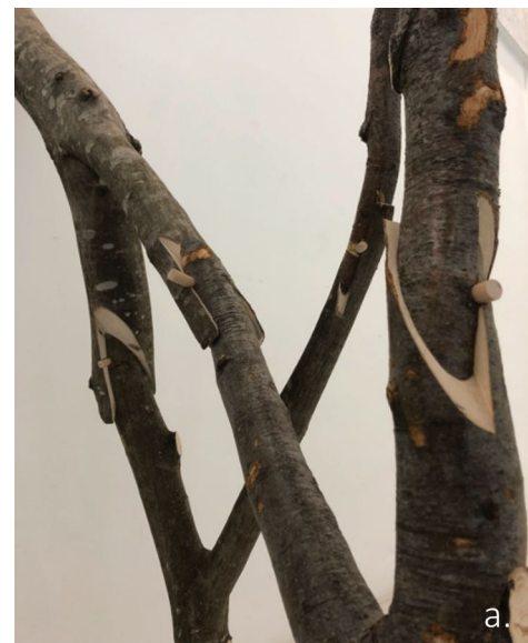
Figure 15 : Log Knot et principe d'assemblage
