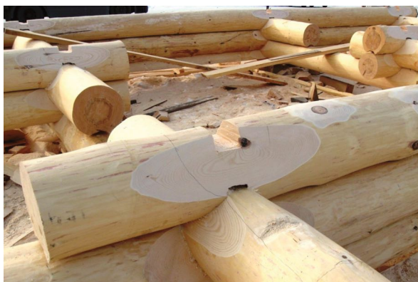
Figure 13 : Assemblage réalisé manuellement
