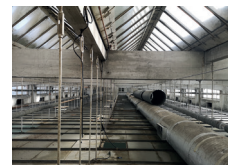
10. Verrière supérieure au dessus du bassin
