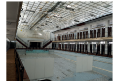
7. vue oblique du bassin
