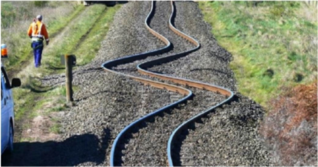
FIGURE 1 – Exemple de flambement de voie
