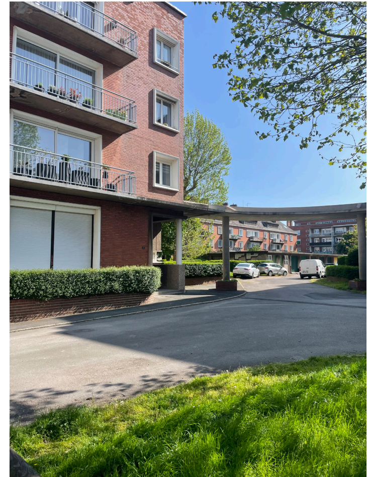
Figure: Crédit photo Baptiste Paulino, «Angle donnant sur coursière et sur un passage»
