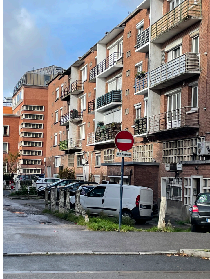
Figure: Crédit photo Baptiste Paulino, îlot rue Royer «Stationnement sauvage en coeur d'îlot et pompes à chaleurs visibles et vétustes»
