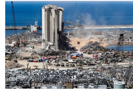
Fig 3: Des creusurs retirent de la terre sur le site de l’explosion à côté des silos du port de Beyrouth le 16 août.
