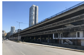
Fig 99: La route Charles Helou et le viaduc
