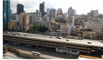
Fig 43: Gare routière Charles Helou, vue aérienne
