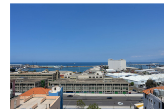
Fig 91: Les Silos de Beyrouth
