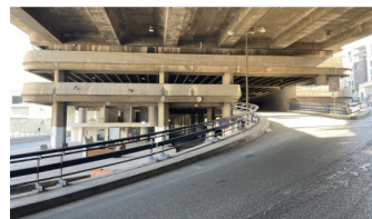
Fig 100: Entrée Ouest du premier étage
