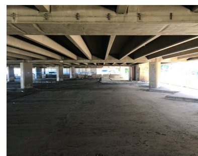
Fig 123: Le viaduc de l'intérieur
