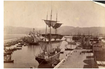
Fig 23: Le port à la suite des travaux de 1886.
