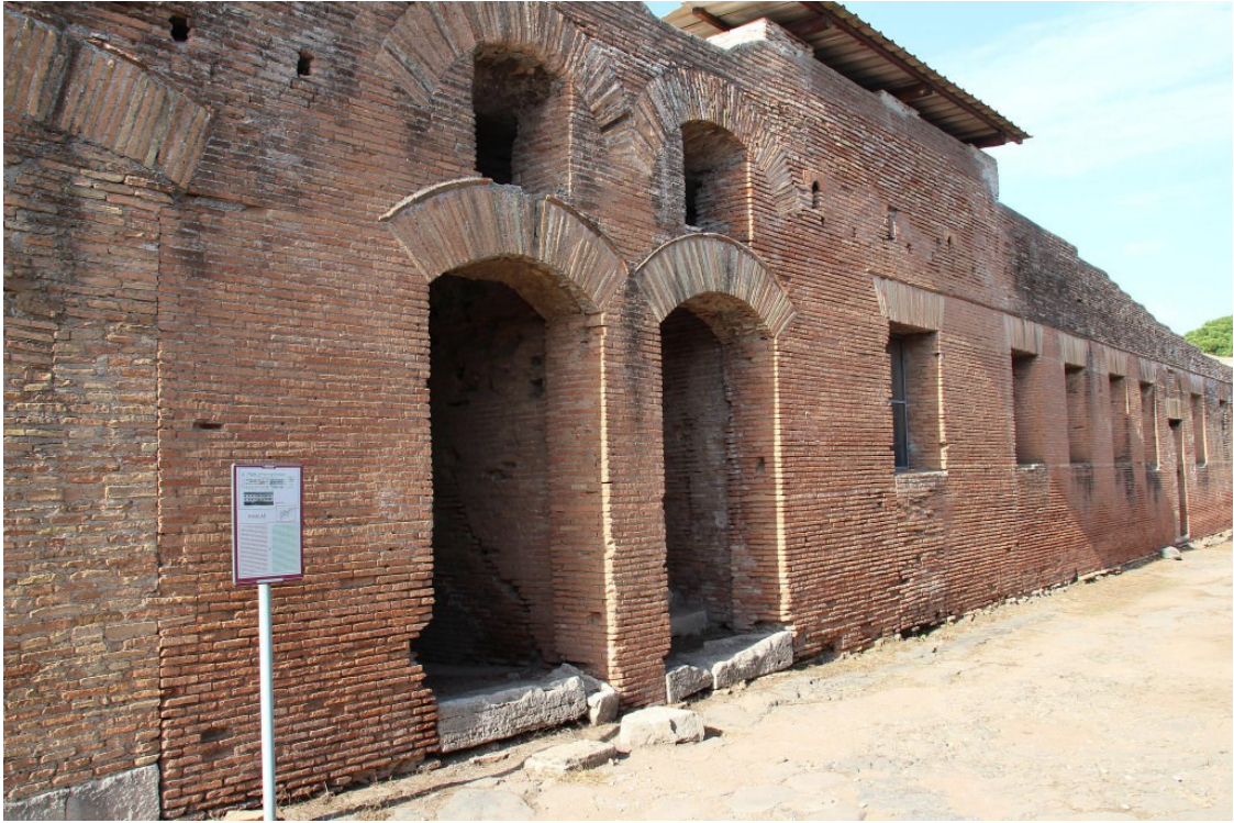
Fig. 90 : Ostie, Casa del Soffitto Dipinti . Photographie de Kl. Heese.
