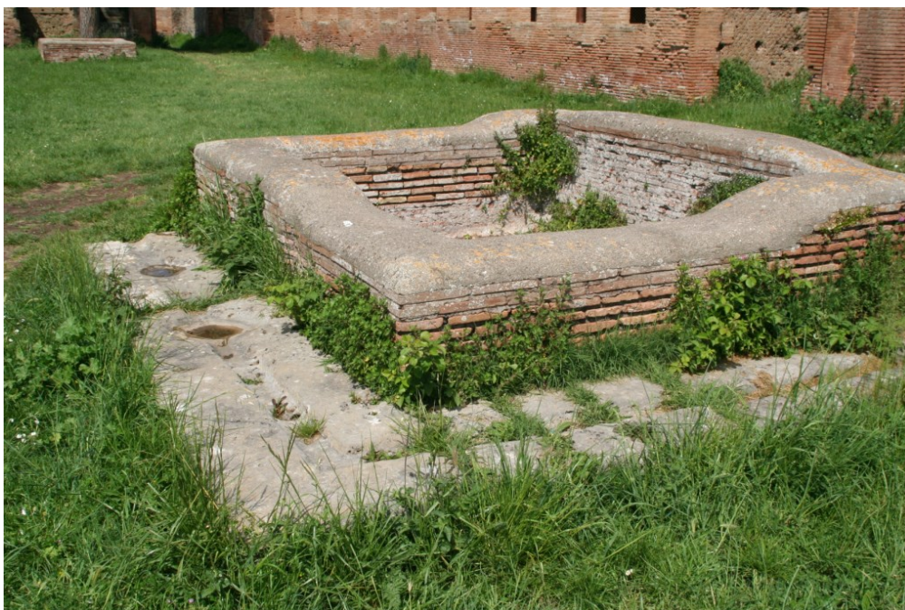
Fig. 11 : Ostie, bassin de la cour des Case a Giardino . Photographie de J. Th. Bakker.
