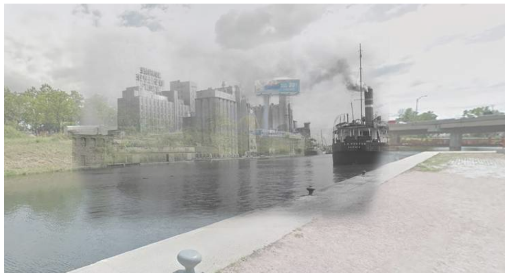
6. SILO À GRAINS DANS LE PAYSAGE MONTRÉALAIS
