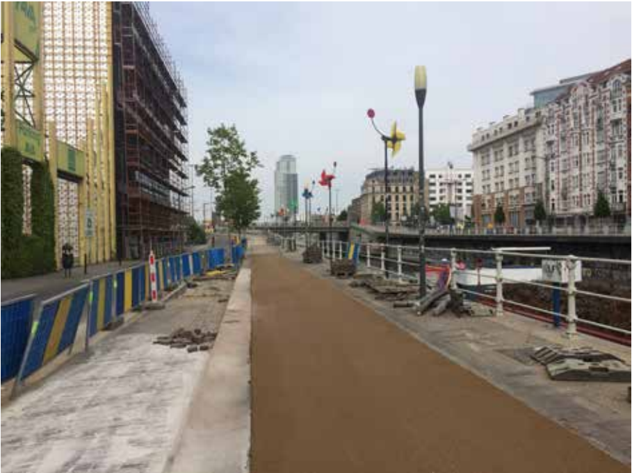
Photo prise par l'auteur, « Piste cyclable en travaux le long du canal », Bruxelles, 22 mai 2020.
