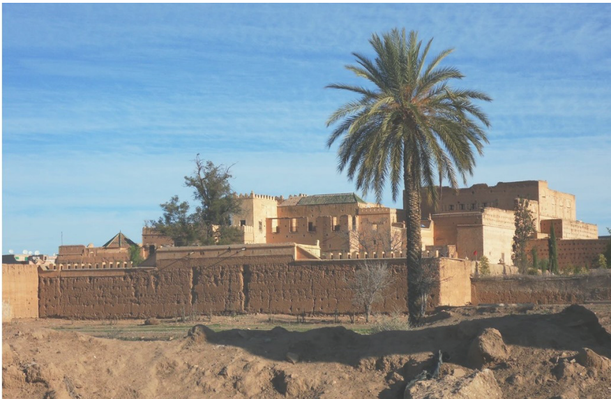
Zaouia de Tamsloht © Ingenieux Sud
