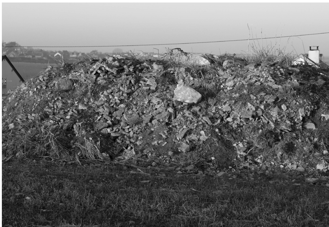
Photographie d'un blockhaus en état de ruine au Pont du Hable ( WN77 - Omaha Beach) Photographie provenant de l'auteur, Lucien LEMERCIER, datant de janvier 2022.
