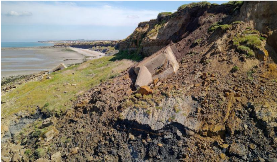
Un morceau de la falaise à Wimereux s'est effondré, entraînant la chute du blockhaus de la Rochette.
