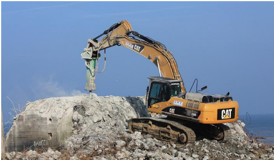
La collectivité a procédé à la destruction des blockhaus situés sur la plage de Wissant.
