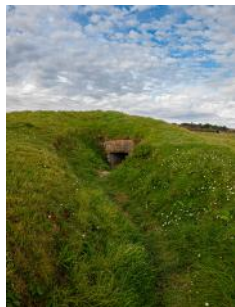
Blockhaus enterré laissant apparaître son entrée. Photographie provenant de l'auteur, Lucien LEMERCIER, datant de janvier 2022.
