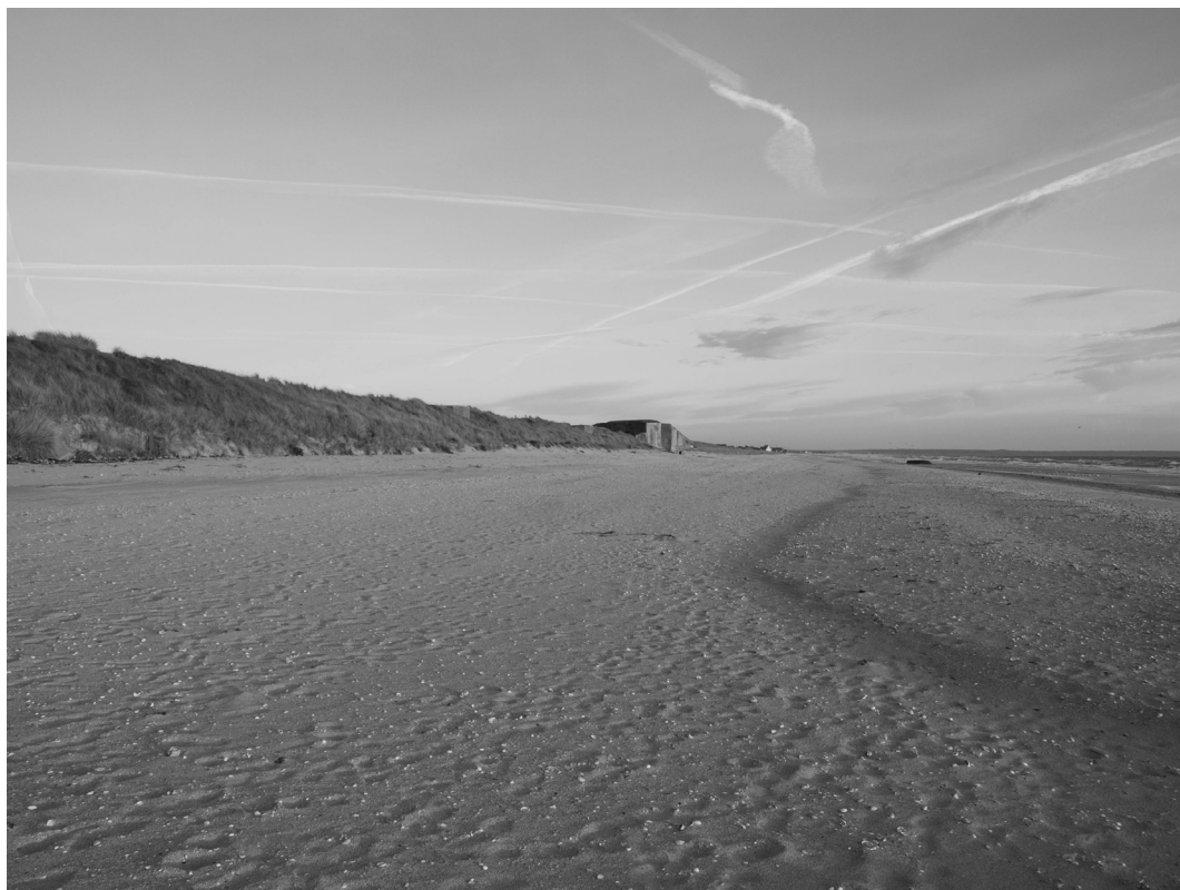
La présente photographie a été prise depuis la plage du site de Saint-Martin-de-Varreville (WN10) et elle montre la ligne de crête du cordon dunaire. En arrière-plan, on peut observer l'un des blockhaus les plus imposants et fortement armés du point d'appui. Photographie provenant de l'auteur, Lucien LEMERCIER, datant du 11 avril 2022.
