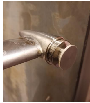
Figure 3 : Anneau dévissé + Plaque avec ressort
