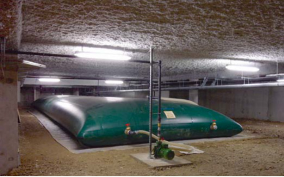
Mise en place d'un système de récupération des eaux de pluie dans les Groupes Scolaires Aimé Césaire
