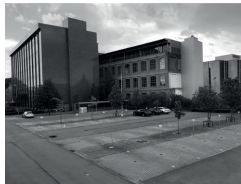
Proximus Anderlecht Pierrick Langerock — 2021 — vue depuis le parking des employés [iPhone]
