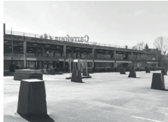
Shopping center de Auderghem Pierrick Langerock — 2021 — vue de la toiture [iPhone]
