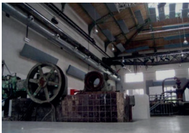
Figure 70c - Ancienne salle des machines
