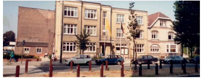
FIGURE 14 - IMMEUBLE DE LOGEMENTS EN 1938 (ARMILLAIRE) Source : a.practice, 2020
