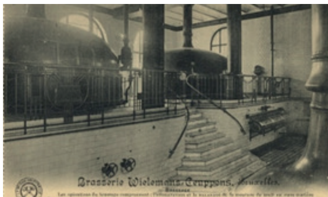
FIGURE 77 - ANCIENNES SALLE DES MACHINES ET SALLE DES CUVES
