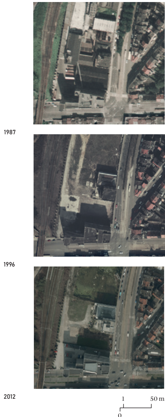
FIGURE 82 - VUES AÉRIENNES DU BRASS (1987, 1996, 2012) Source : Bruciel, 2023
