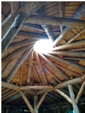
Figure 1.1: Charpente réciproque en grumes [ [24]
