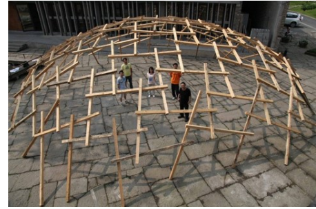
Figure 2.11: Exemple de structure avec assemblage non-rigide [20]
