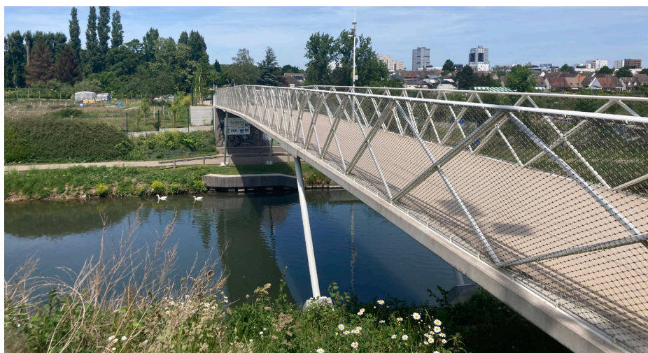
Parc du burien - la passerelles vers St Nicolas
