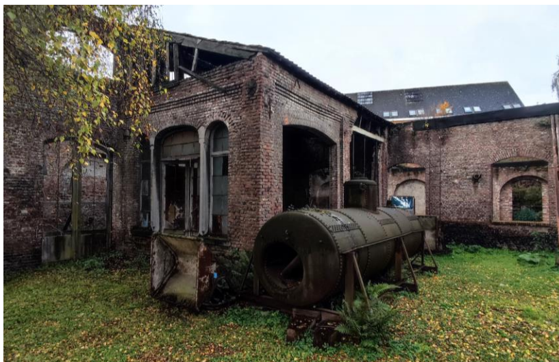
Figure 66 : Vue extérieure de l'atelier des sculpteurs – Photo personnelle -
