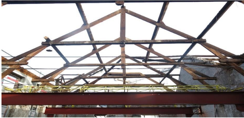
Figure 86 : Travaux de consolidation et restauration de la charpente – Bureau Greisch-
