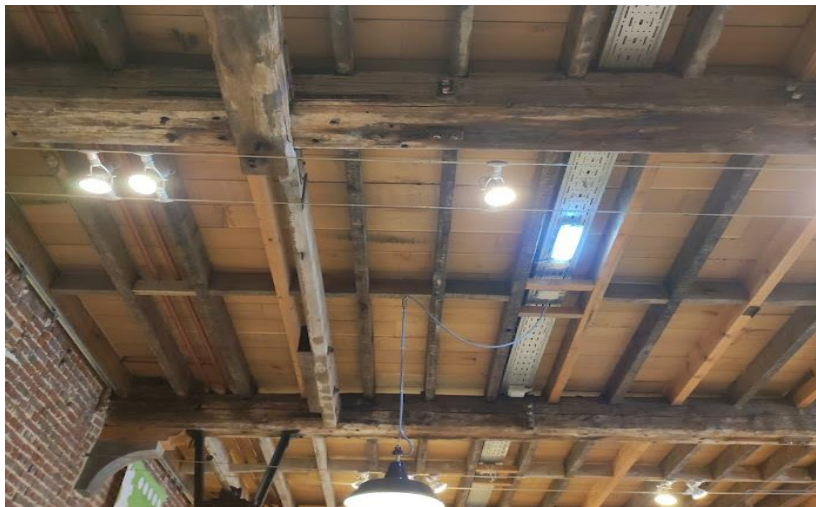
Figure 127 : Vue actuelle sur le plancher de la salle des dessinateurs – Photo personnelle
