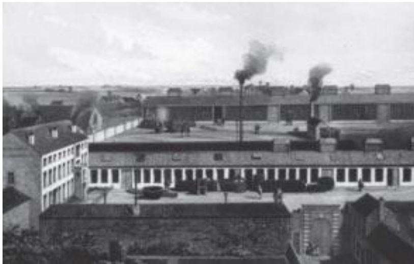
Figure 32 : L'usine Cail, Halot et Compagnie, vers 1850, extrait de La Belgique industrielle - Source La Fonderie -
