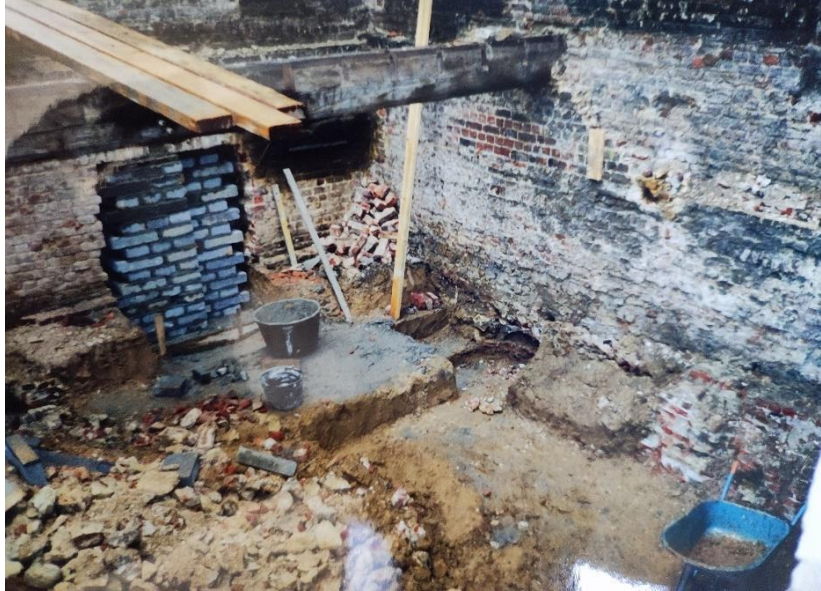
Figure 112 : Reprise en sous œuvre sur la halle des tourneurs – Source Archives La Fonderie -
