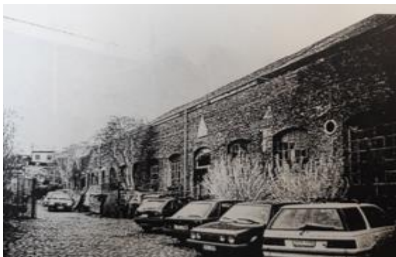
Figure 96 : Vue sur la halle des tourneurs avant travaux 1981 – Source archives la Fonderie –
