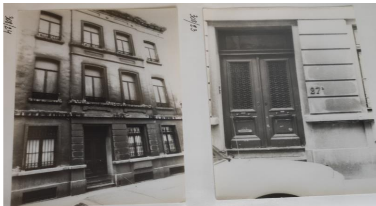
Figure 53 : Photo de l'état de la maison du directeur en 1973 – Source la Fonderie-
