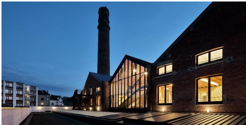
Figure 87 : Création d'un bâtiment de jonction -Jacques Delens sa - ROTOR
