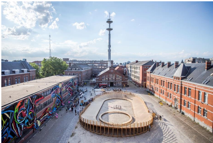
Figure 93 : vue aérienne de l'installation du parcours pour vélos – Source site web See U -
