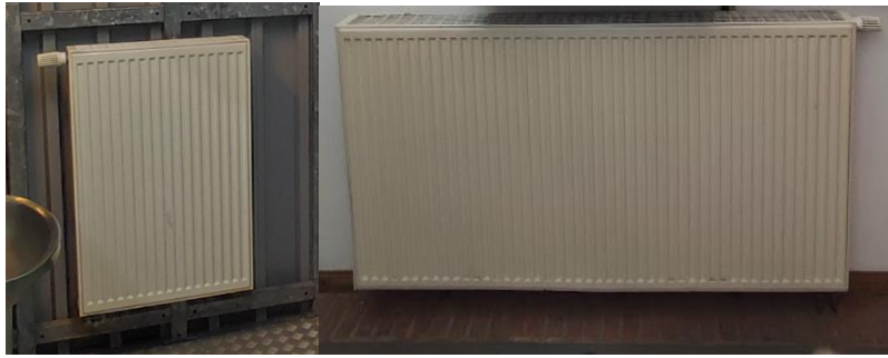
Figure 135 : Radiateur en acier à convection – Photo personnelle -
