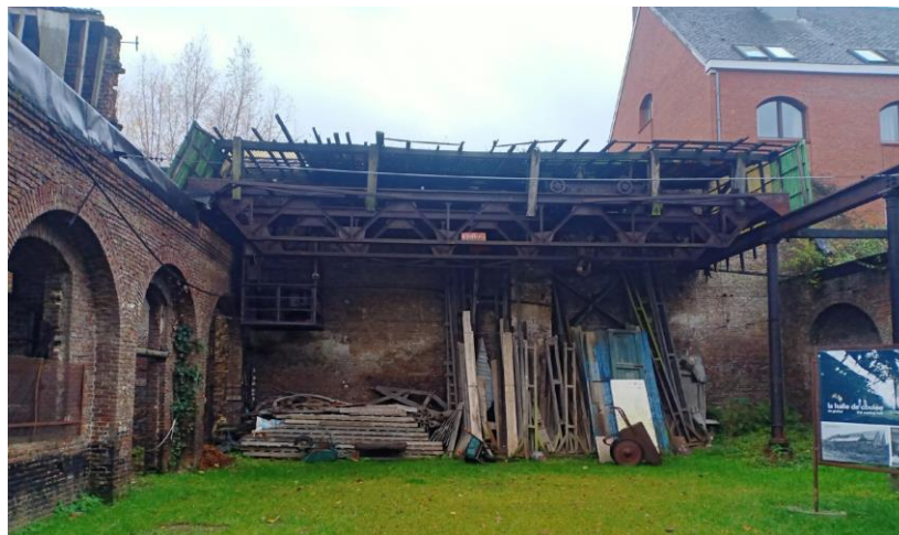
Figure 62 : Vue actuelles sur les arcades et le pont roulant – Photos Personnelles -
