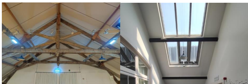
Figure 129 : vue actuelle sur les fermes et les fenêtres de toit de la halle des tourneurs – Photo personnelle-
