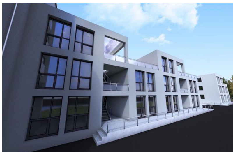
Figure 15 : Ensemble d'appartements Pont-à-Celles, fin du chantier (Devaux, 2016)
