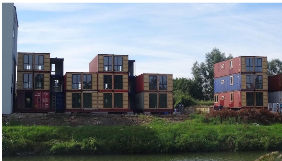
Figure 14 : Ensemble d'appartements Pont-à-Celles, début du chantier (Devaux, 2016)
