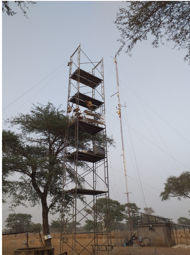
Photo 2: Arbre 5, échafaudage installé au Sud de la couronne et tour à flux de l'observatoire de recherche « Faidherbia-flux » à Niakhar
