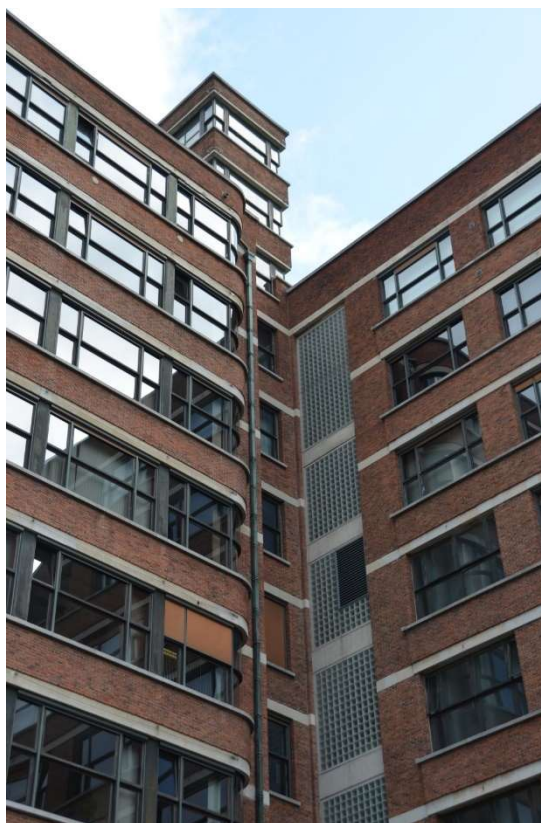
Images 34, 35 : Hall d'escaliers principale vue d'intérieure et d'extérieure
