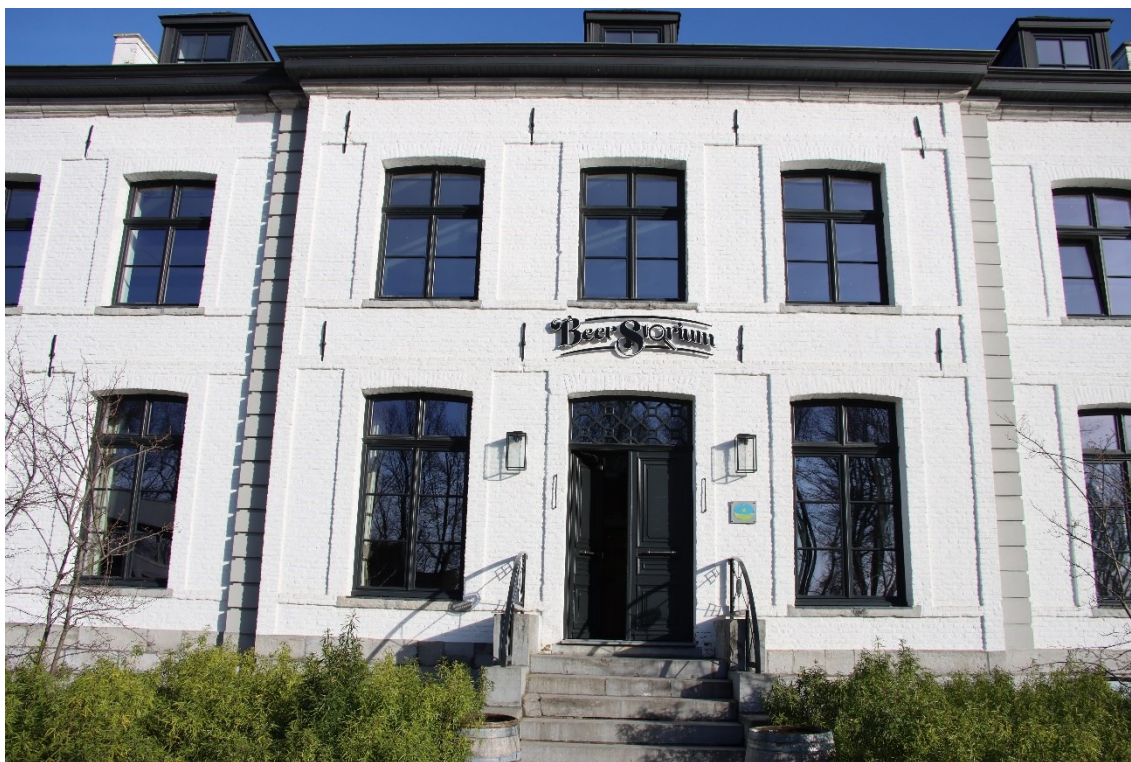
Photographie 1 - Entrée du Beerstorium/Château de Ghysssegnes
