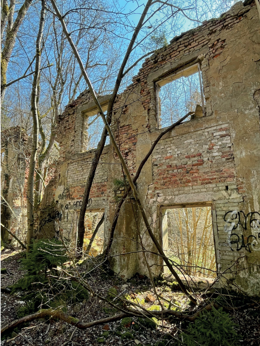
Fig. 1 Ruine d'une maison abandonnée à Clairefontaine, photo de PAULET Céline
