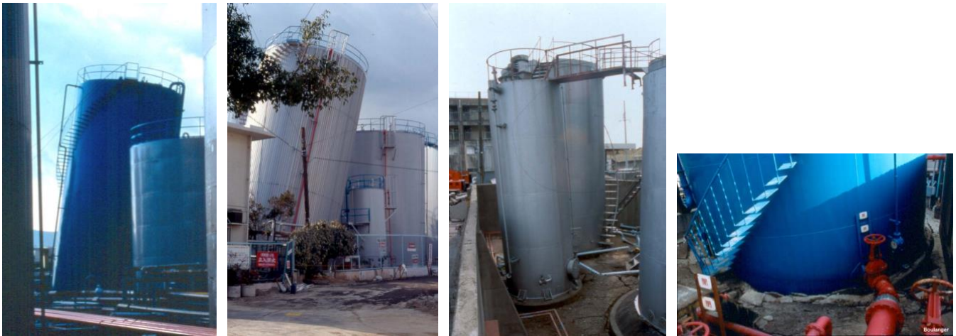
Figure 2 : Illustrations de cas réels de réservoirs avec tassement différentiel.
