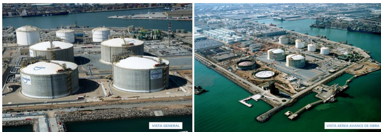
Figure 1 : Exemple de réservoirs de stockage de grande dimension.
