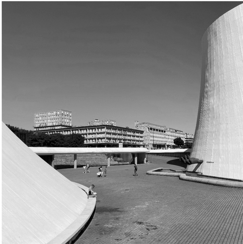
Figure 2 : Photo in situ du centre-ville
