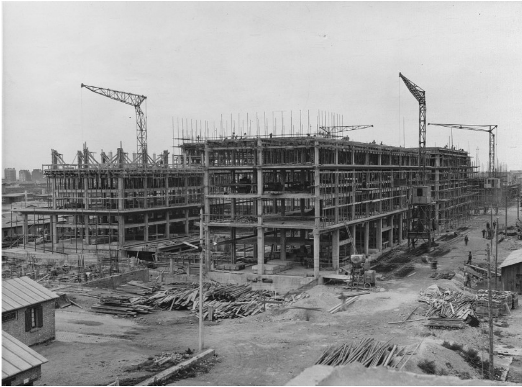
Figure 12 : photo d'archive du chantier des ISAI
