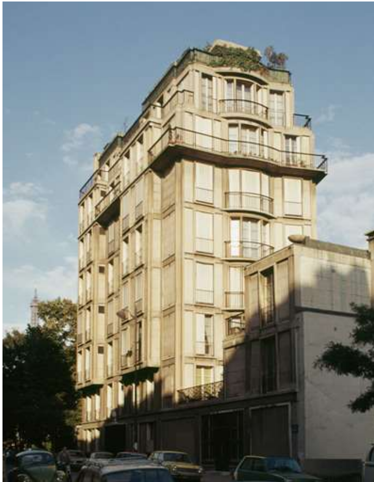
Figure 19 : immeuble de rapport de la rue Raynouard
