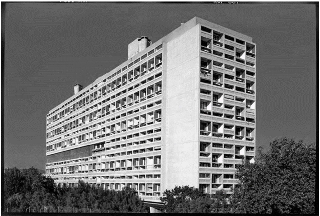
Figure 34 : cité radieuse de Marseille, Le Corbusier
