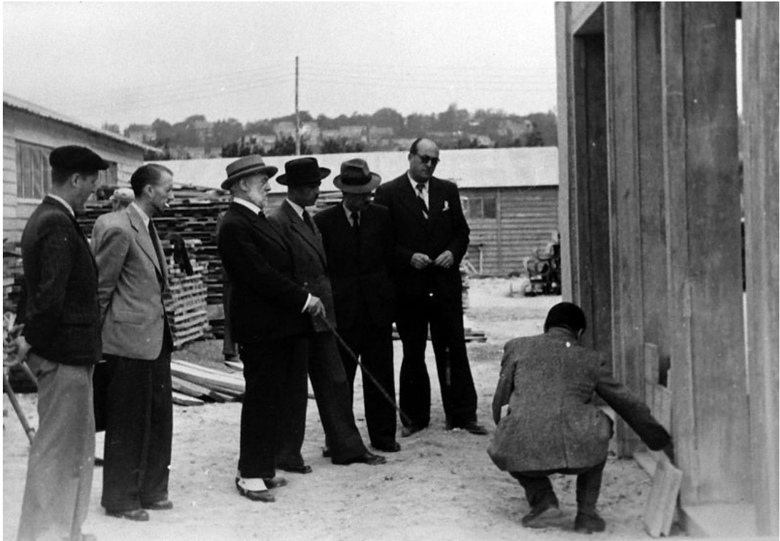
Figure 37 : Les architectes de l'atelier Perret sur chantier
