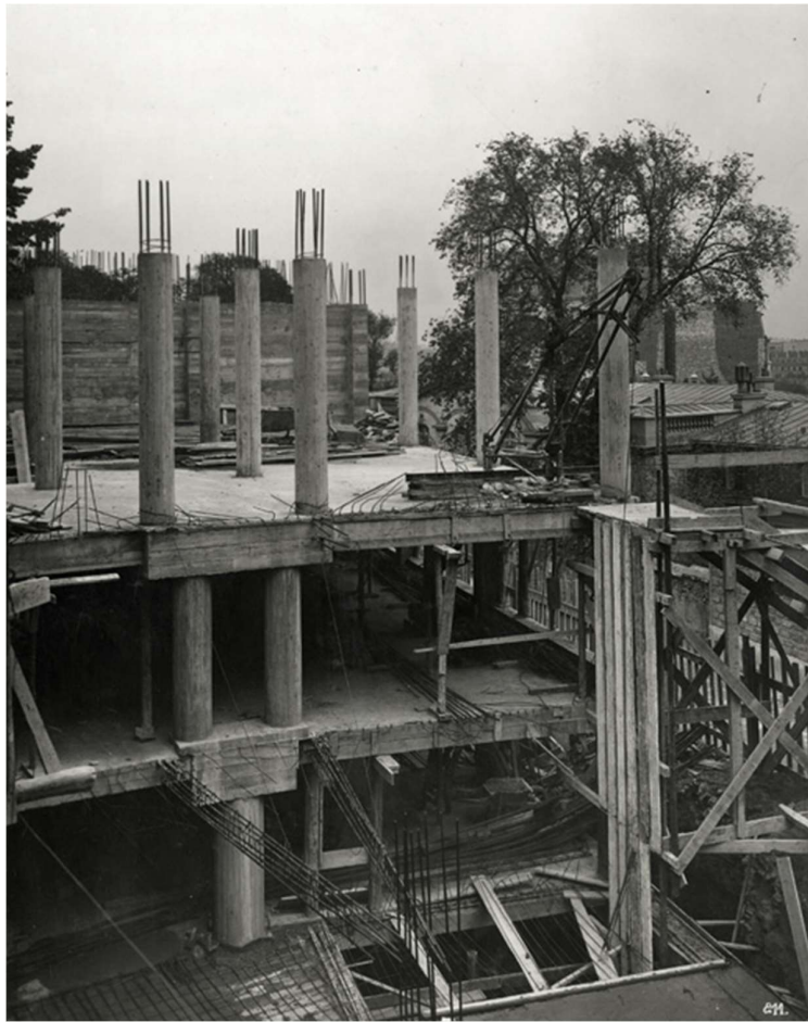
Figure 15 : photo d'archive d'un chantier des frères Perret
