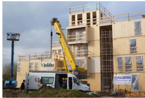
Figure 4 - Les closières, Mont-sur-Marchienne, 2015, Rez+4
