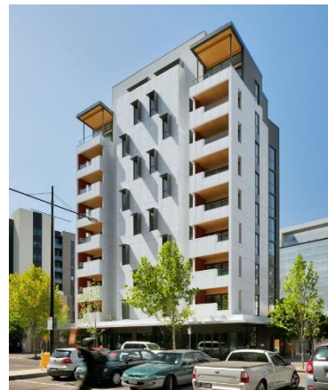
Figure 2 - Forte Living, Melbourne, 2012, hauteur de 32m
