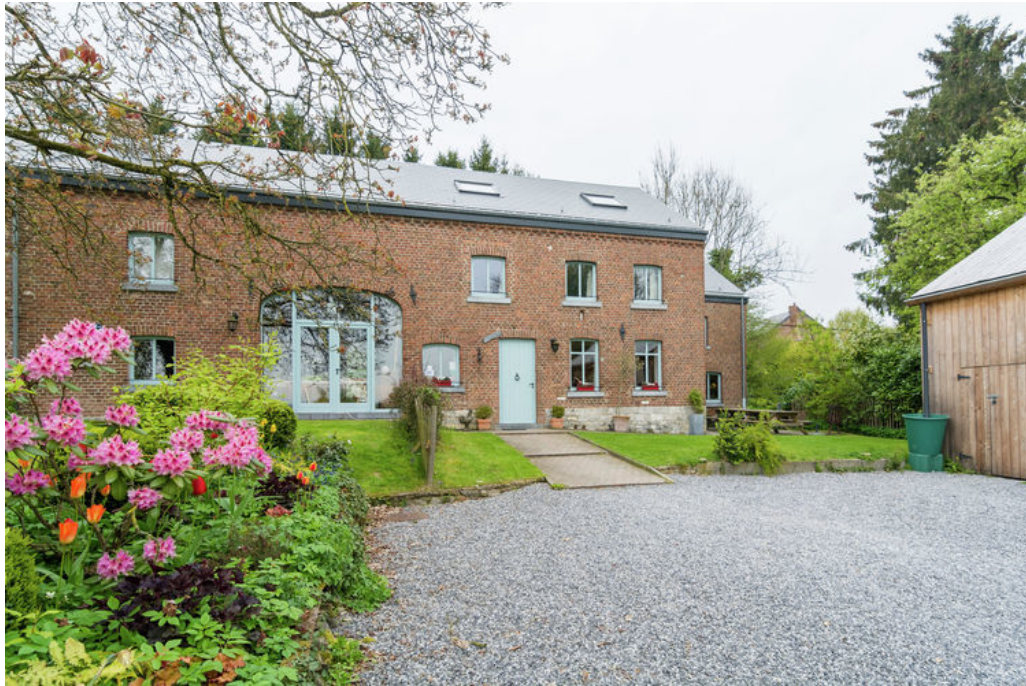
Figure 30. The Grange d'Ychippe (La Grange d'Ychippe, 2019)
