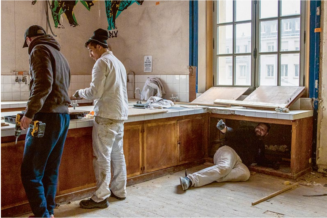
Fig. 48 – Outil de l’urbanisme temporaire : Participation collective, délégation et réemploi Démarche collective de rénovation lors d’un chantier d’apprentissage à l’Hôtel Pasteur Source : Estève, Anne-Cécile, Rénovation des paillasses encadrée par l’association Les Compagnons Bâisseurs , Fig. 9., 2020, Rennes.
