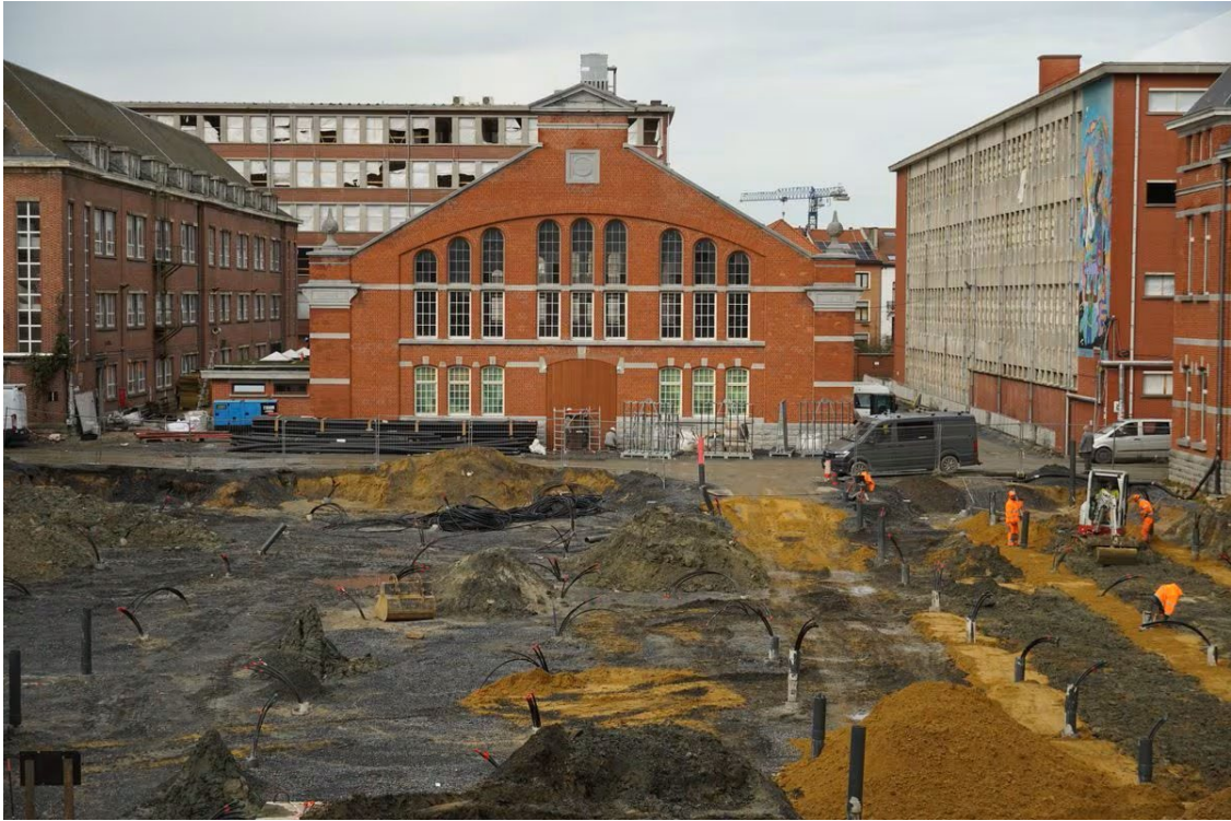
Fig. 39 Première phase de travaux au niveau des casernes d'Ixelles Source : L'avenir, sans titre , date inconnue, Bruxelles.
