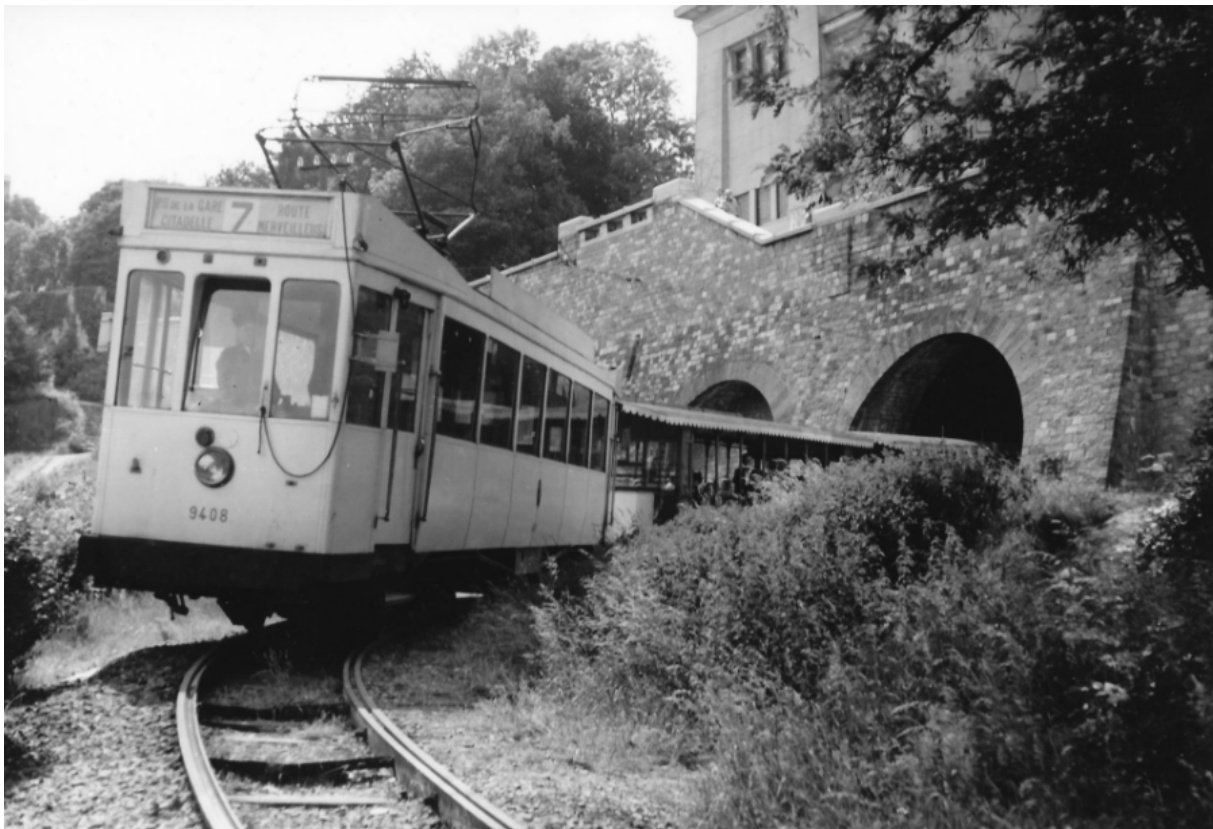
Fig. 65 Le passage du tram au niveau du tunnel sous le bâtiment, entre 1901 et 1923. Source : Marchal, Jacky, Sans titre , date inconnue, Namur.
