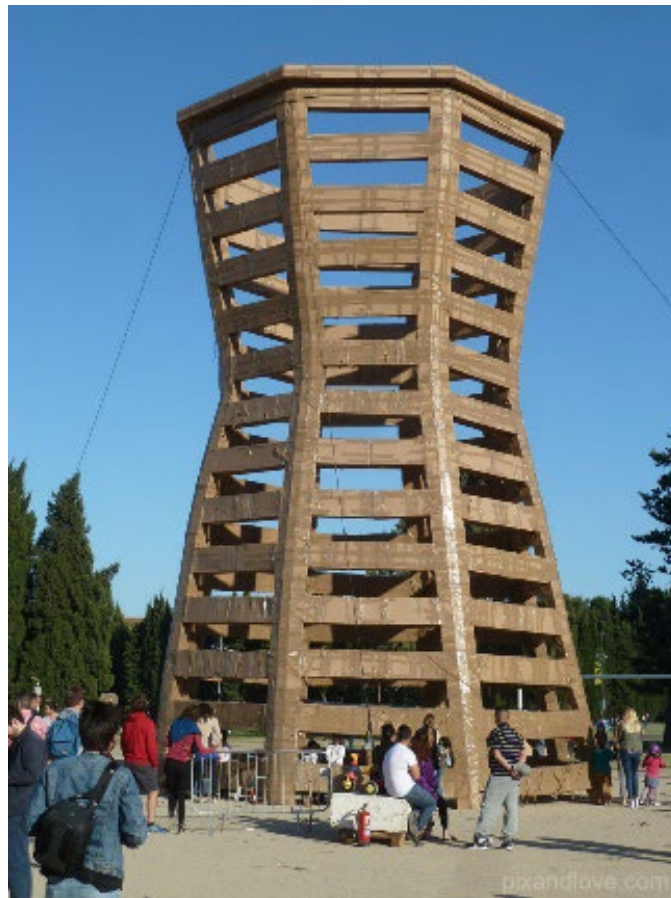
Fig. 13 Structure ZAT installée au Parc Montcalm à Montpellier Source : pixandlove, Parc Montcalm , 2017, Montpellier.
