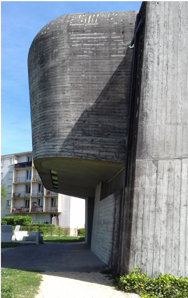
Façade principale, vue latérale
