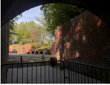
Vue sur les casemates depuis l'entrée du musée. Fig.70
