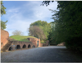
Casemates du Fort Lobau, toujours debout. Fig.71
