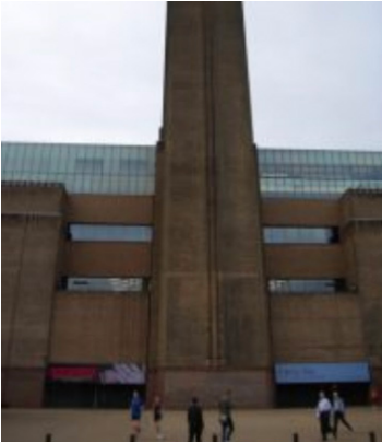
Photographie tirée du site Post Tourisme Londres. Entrées au niveau du socle de la cheminée. Fig.26
