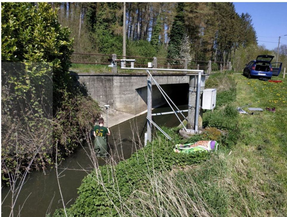
FIGURE 3.16 – Photo de la Ligne à Saint Martin [25]
