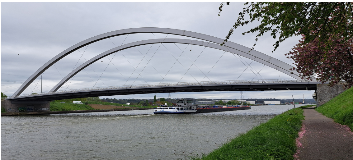
FIGURE 6.1 – Pont de Haccourt.
