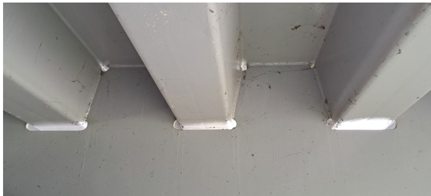
FIGURE 6.20 – Augets continus à travers les entretoises.
