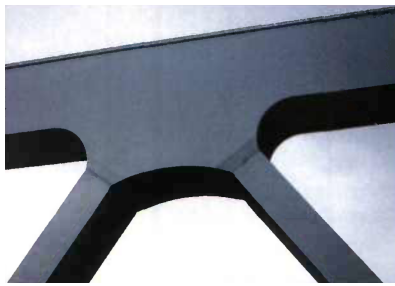
FIGURE 2.14 – Noeud de treillis Warren : goussets circulaires [26].
