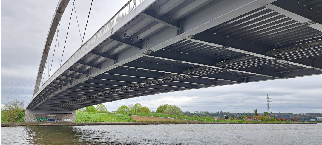
FIGURE 6.11 – Tablier du pont : dalle orthotrope.
