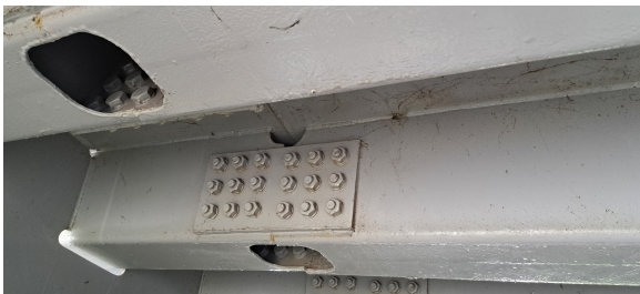
FIGURE 6.12 – Assemblage dalle orthotrope : entretoise, auget et platelage.
