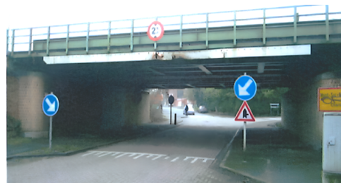
FIGURE 3.4 – Pont-rail métallique à Marchienne-au-Pont [18].
