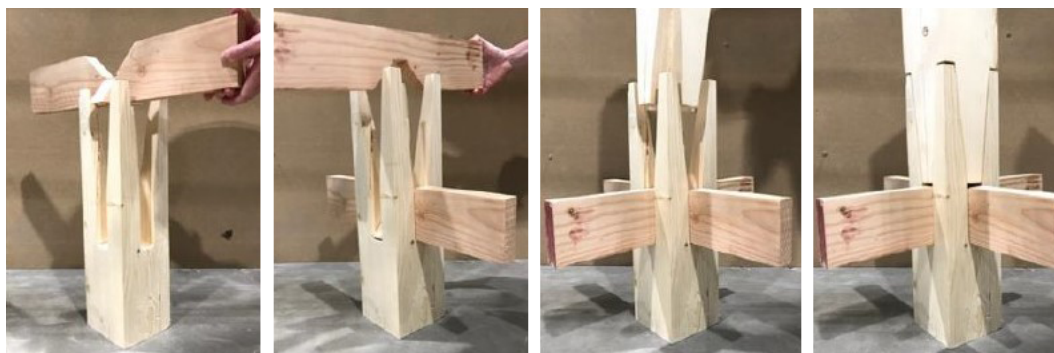
FIGURE 3.7 – Assemblage en bois drone-compatibles C. Manderlier et T. de Furstenberg (2017)
