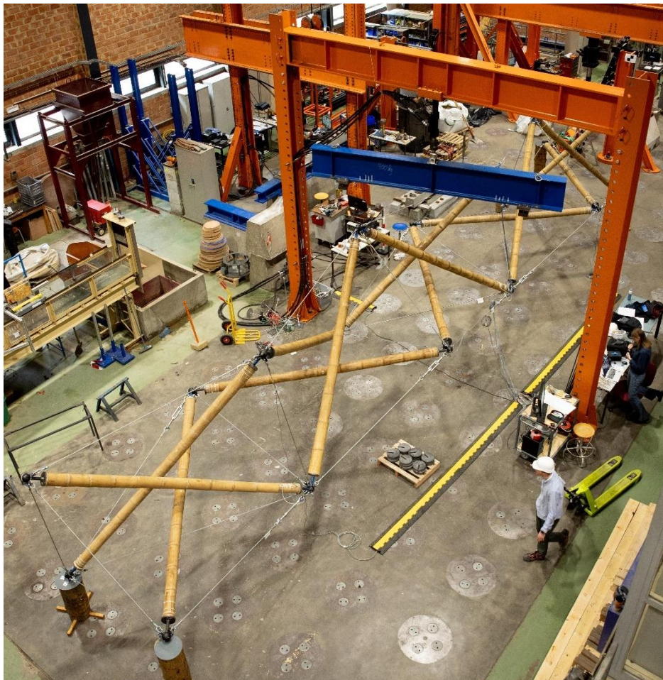
Figure 6.1 – Montage de la structure complète en mai 2023
