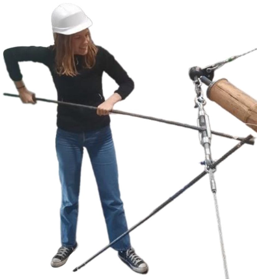
Figure 6.17 – Raccourcissement d'un tendeur à l'aide d'un bras de levier (en réalité Violette y arrive sans !!!)
