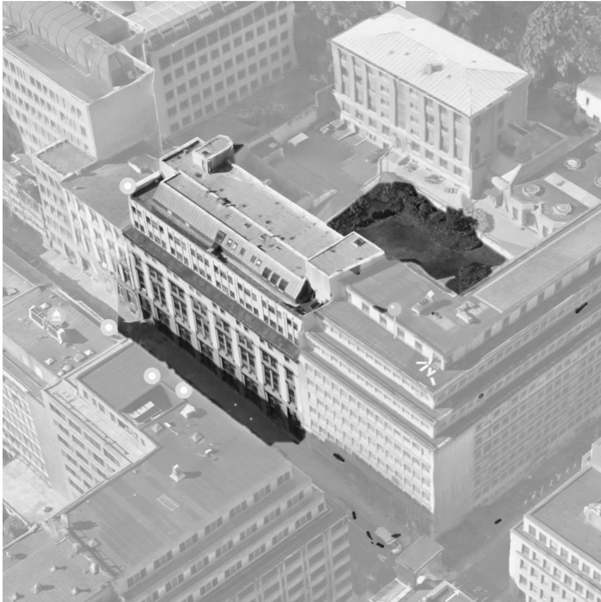
Figure 37 : Rue d'Arlon n°94-102
