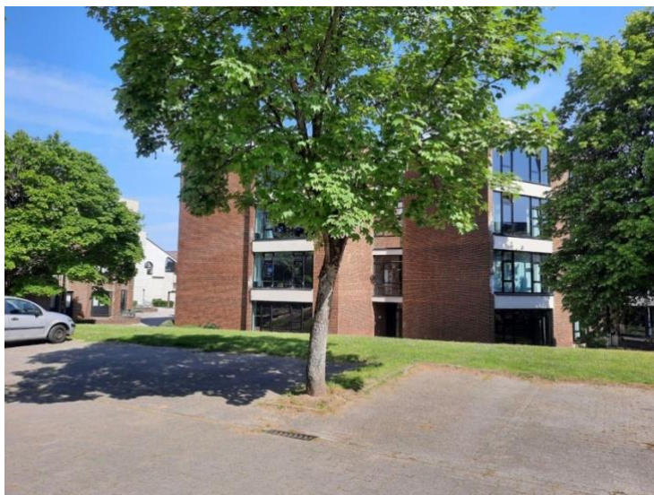
Figure 12 – Exemple d'un site artificialisé (Parking Sainte-Barbe) à Louvain-la-Neuve
